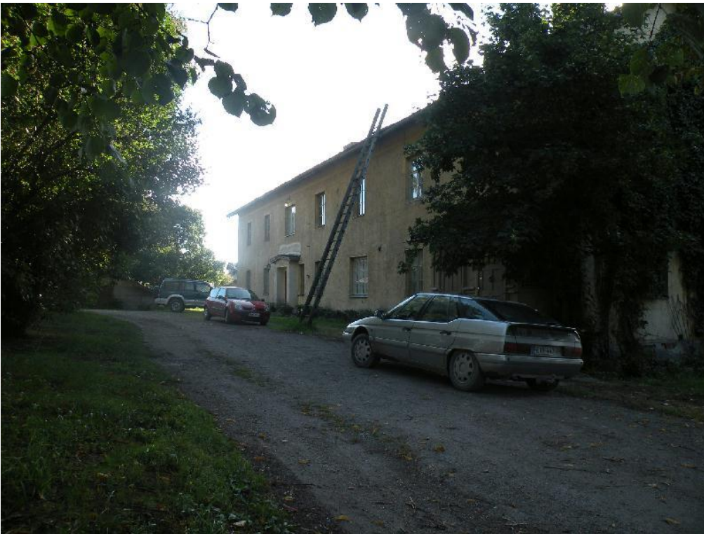
Kuva 6. Tampere Sorila (Sorrila), Kulkkaan päärakennus. Kuvattu länsiluoteesta. (DSCN2027_38)
