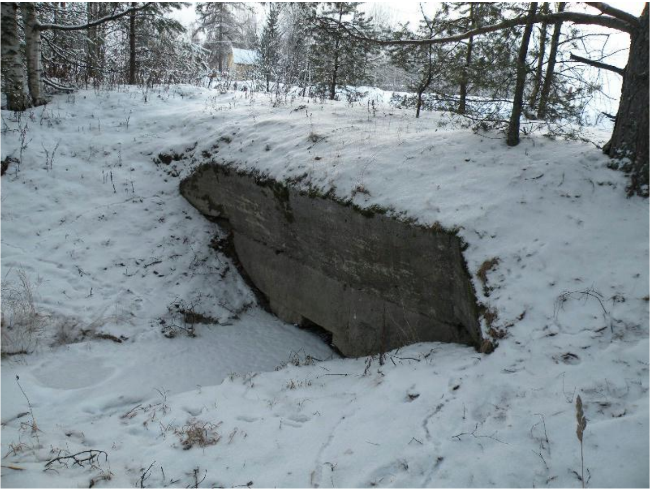
Kuva 48. Kohde Messukylä – Ruovesi Nurmi 2, nuorehko betonisilta. Kuvattu koillisesta. (DSCN2927_101)
