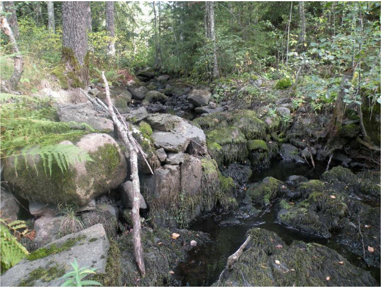
Kuva 41. Myllymoision myllynpaikan pohjoisempi patovalli. Kuvattu lounaasta. KYY 53: 12, (DSCN2003_36)
