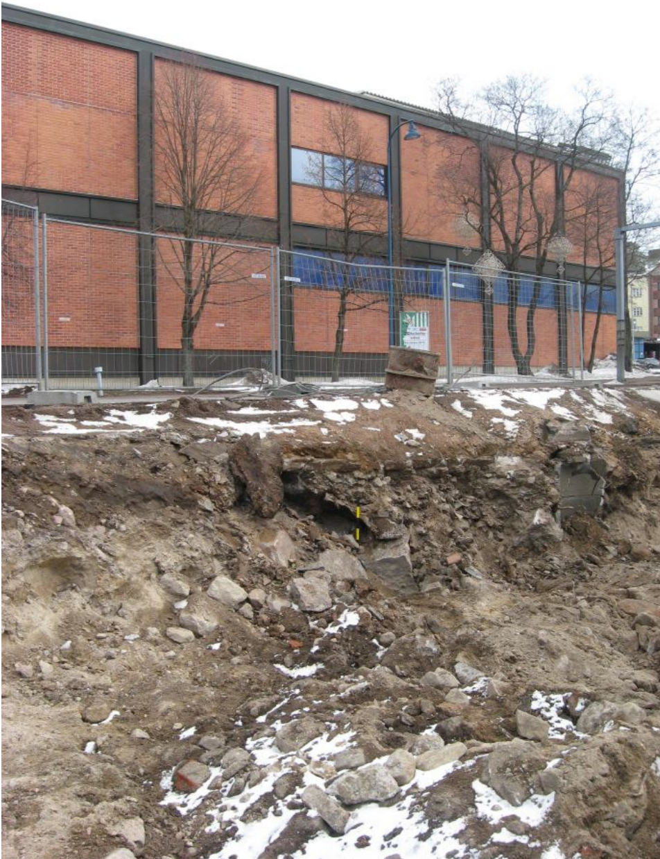
Kuva 24: Kanavan Koulukadun puoleinen pää jalkakäytävän leikkauksessa kuvattuna keskeltä kanavalinjausta. W. Kuva KyM/M. Kykyri.
