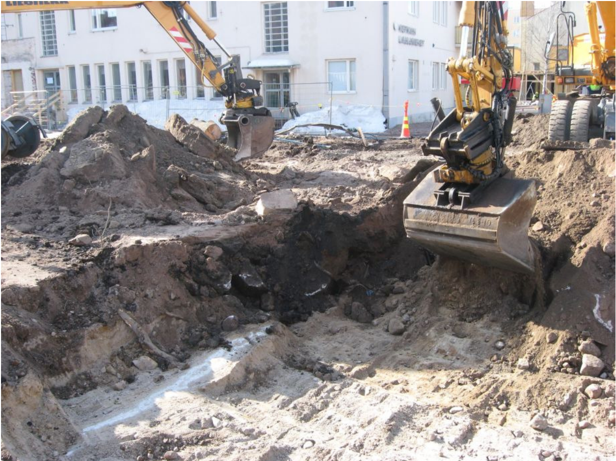
Kuva 17: Koeojan ja koekuopan kaivun jälkeen tonttialuetta ryhdyttiin syventämään kahdella kaivinkoneella. Kuva-alan keskellä näkyy ympäröivästä maasta tummemman värinsä puolesta erottuva kanavauoma kivitäyttöineen. Alhaalla vasemmalla näkyy esiin kaivettua peruskallion pintaa. N. Kuva KyM/M. Kykyri.
