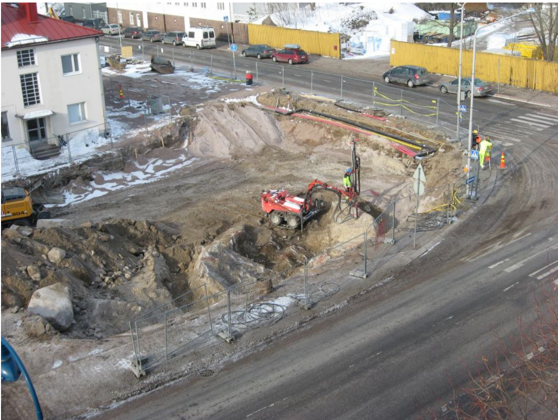
Kuva 26: Kallioon louhittua kanavauomaa porataan ennen räjäytystöitä. E. Kuva KyM/M. Kykyri.
