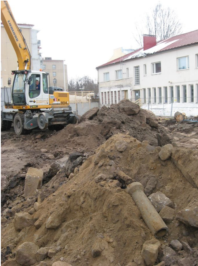
Kuva 18: Hiekkakerroksen poistamisen yhteydessä ylöskaivettuja kiviä ja betonisia viemäriputken katkelmia. NW.
