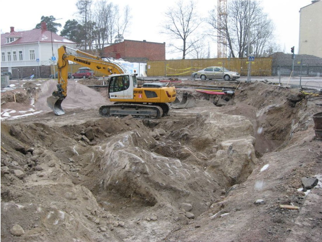
Kuva 25: Kallioon louhittu kanavauoma lähes pohjaan kaivettuna. E. Kuva KyM/M. Kykyri.
