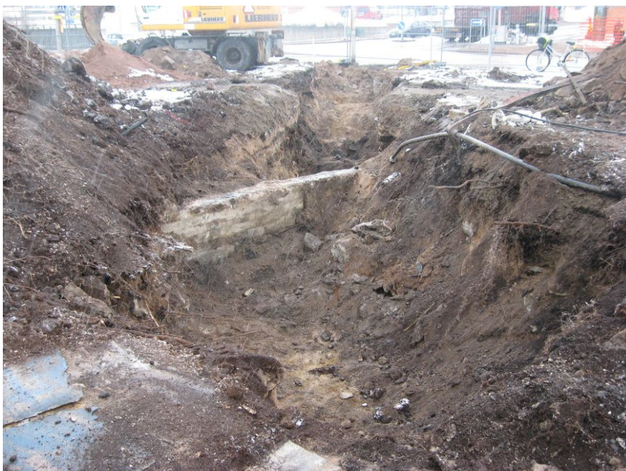
Kuva 12: Betonisen perustuksen NW-pääty kulki koeojan S-pään halki. S.
