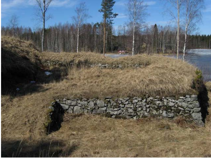
Kuva. Varustuksen pohjoisosaa. Päivi Hakanpää RHOA 125859:27.
