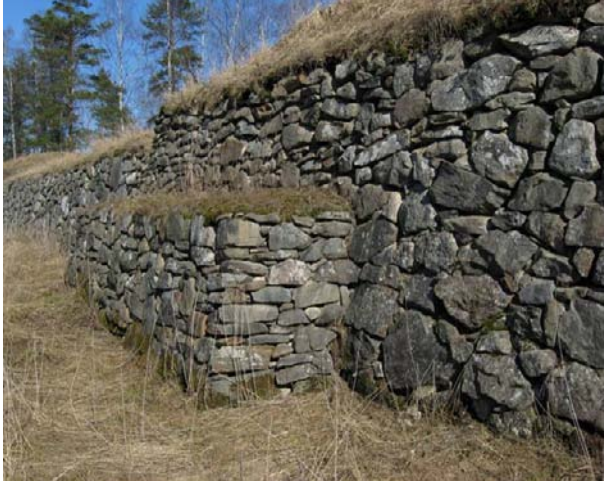
Kuva. Puolibastionin oikea siipi oli tuettu erillisellä kivimuurilla. Päivi Hakanpää RHOA 125859:19.
