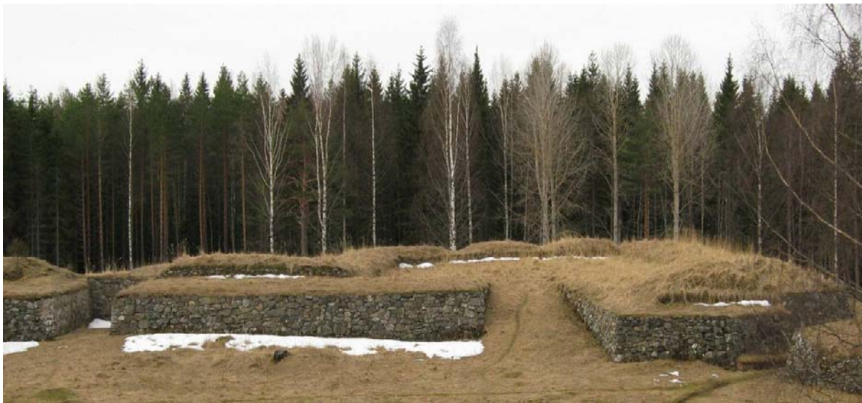
Kuva. Eteläinen puolibastioni. Päivi Hakanpää RHOA 125859:15.
