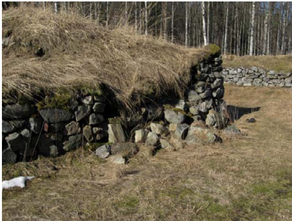
Kuva. Takasivun sortunut tukimuuri ennen korjausta ja korjausten jälkeen. Päivi Hakanpää RHOA 125859:7–8.
