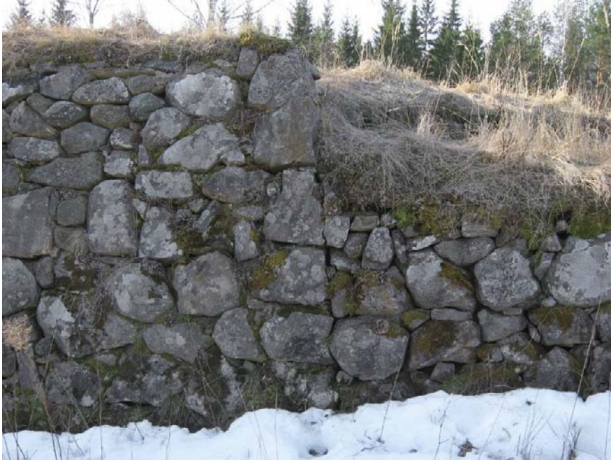
Kuva. Raveliinin takasivun ja vasemman kyljen kohdalla on muuraussauma. Päivi Hankapää RHOA 125859:11.
