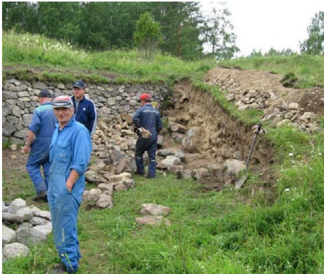
Kuva. Maaluiskan tukimuurin korjaukset olivat käynnissä heinäkuussa 2008. Päivi Hakanpää RHOA 125859:13.
