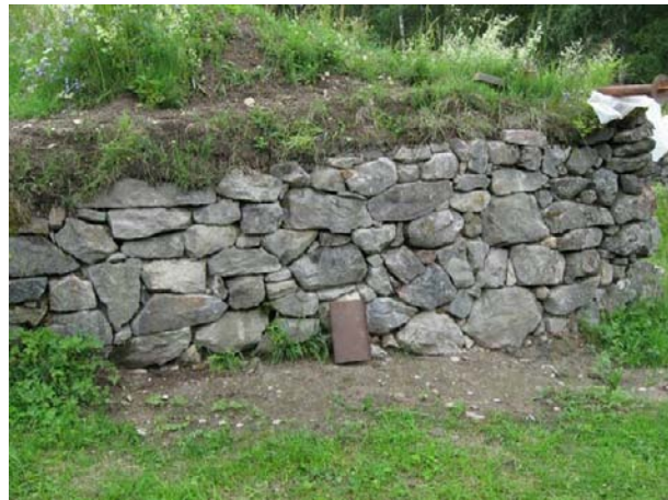
Kuva. Takasivun sortunut tukimuuri ennen korjausta ja korjausten jälkeen. Päivi Hakanpää RHOA 125859:7–8.
