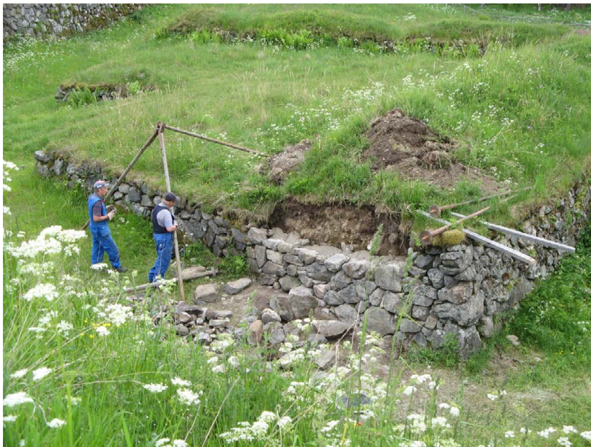
Kuva. Raveliini B:n takasivun tukimuurin korjaukset aloitettiin kesäkuussa 2008. Päivi Eronen RHOA 125859:9.
