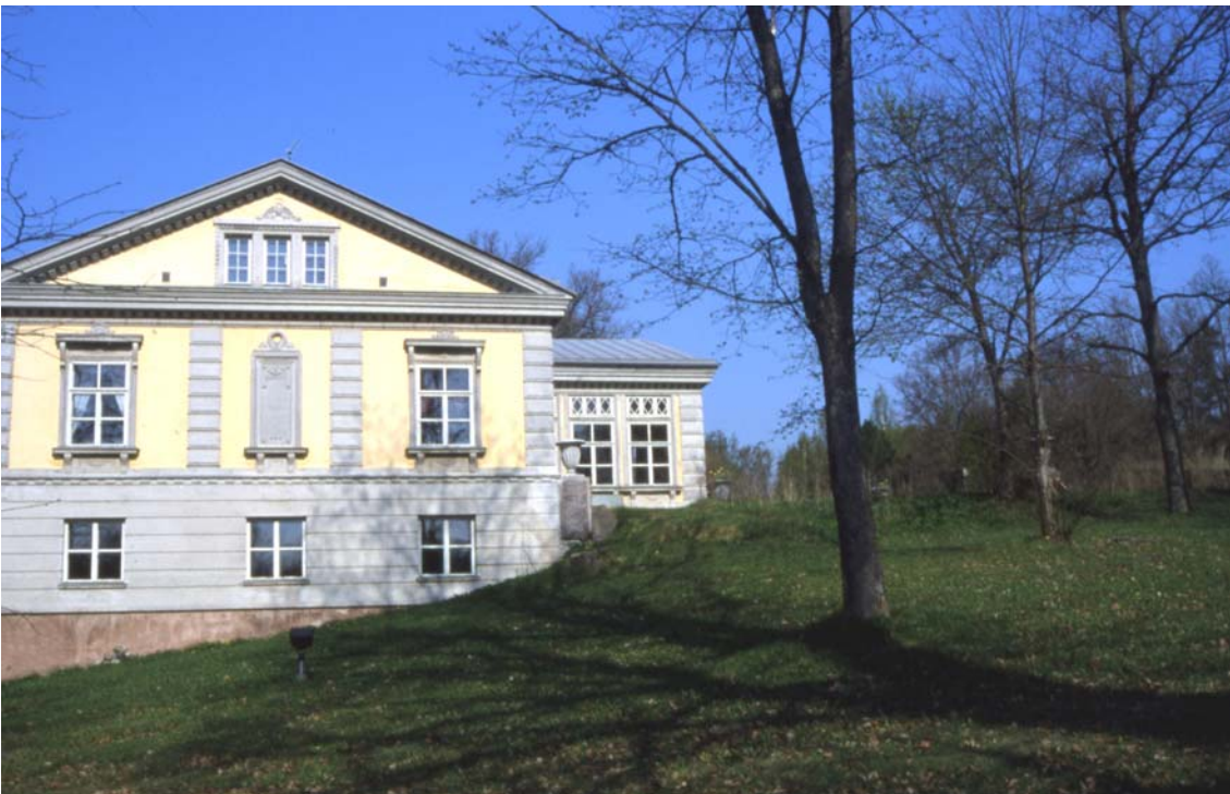
Espoonkartanon päärakennus ja sen oikealla puolella terassi, joka peittää vanhan päärakennuksen rauniot. (MV/RHOA Dia 125516: 40/GH)
