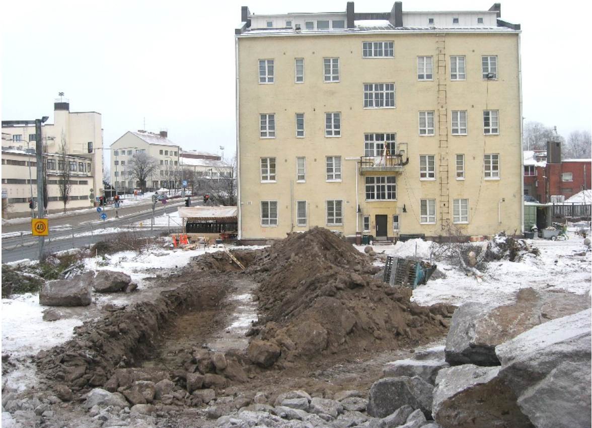
Kuva 7: Koeoja pohjaan kaivettuna. SW. Kuva KyM/M. Kykyri.
