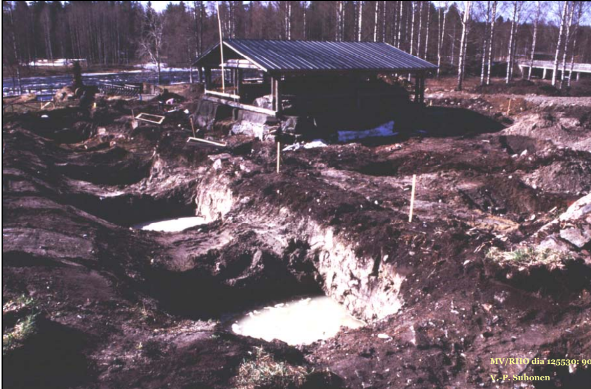
Kuva 5: Uuden suojakatoksen perustuksia varten kaivettuja kuoppia.
