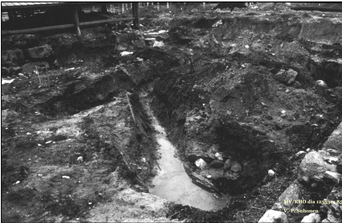
Kuva 1: Salaojaputken paikat masuunin raastuvan pohjoispuolella.
