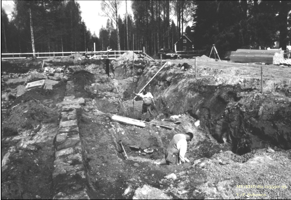
Kuva 4: Uuden suojakatoksen perustuksia tehdään.
