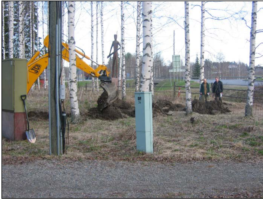
Koeojaa 1 kaivetaan. Taustalla Iisalmi – Oulu-maantie.
