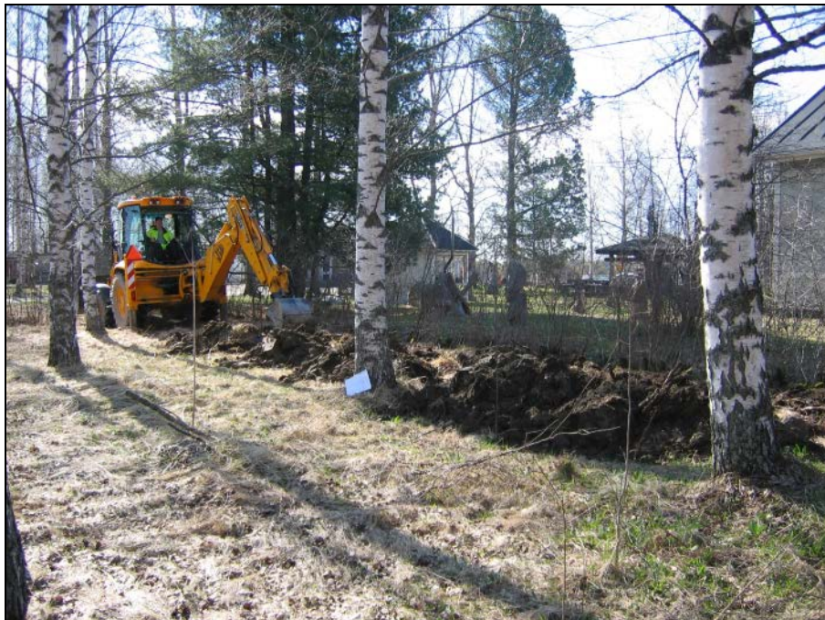
Koeojaa 4 kaivetaan. Kuvan oikeassa reunassa näkyy Kauppilan tilan nykyistä päärakennusta.
