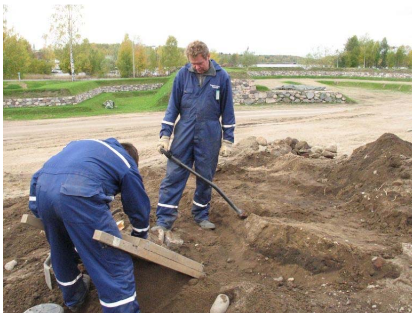
Kuva 11. R 4:ää kaivetaan.
