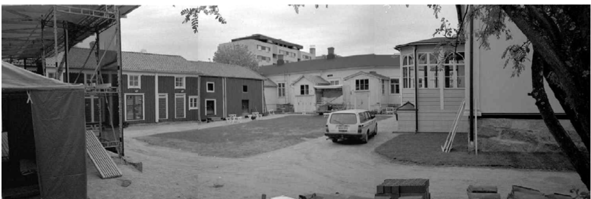
MV:RHOA 125171: 26-28. Pietarsaaren alkuperäisessä asemakaavassa tontin 1-1-9 poikki kulki ”Läntinen pitkäkatu”, jonka kivetty linjaus paljastui sisäpihalta keväällä 2002 kaivutöiden yhteydessä. Kivetty katulinja tuli esiin tontin lounaisosassa, kuvassa näkyvän nurmialueen vasemmasta reunasta. Piha-alueen kerrostumat ovat oletettavasti pääosin säilyneitä. Kuvassa vasemmalla väliaikainen esiintymislava. Kuva on otettu tontin kaakkoiskulmasta. Kohti NW-N.
