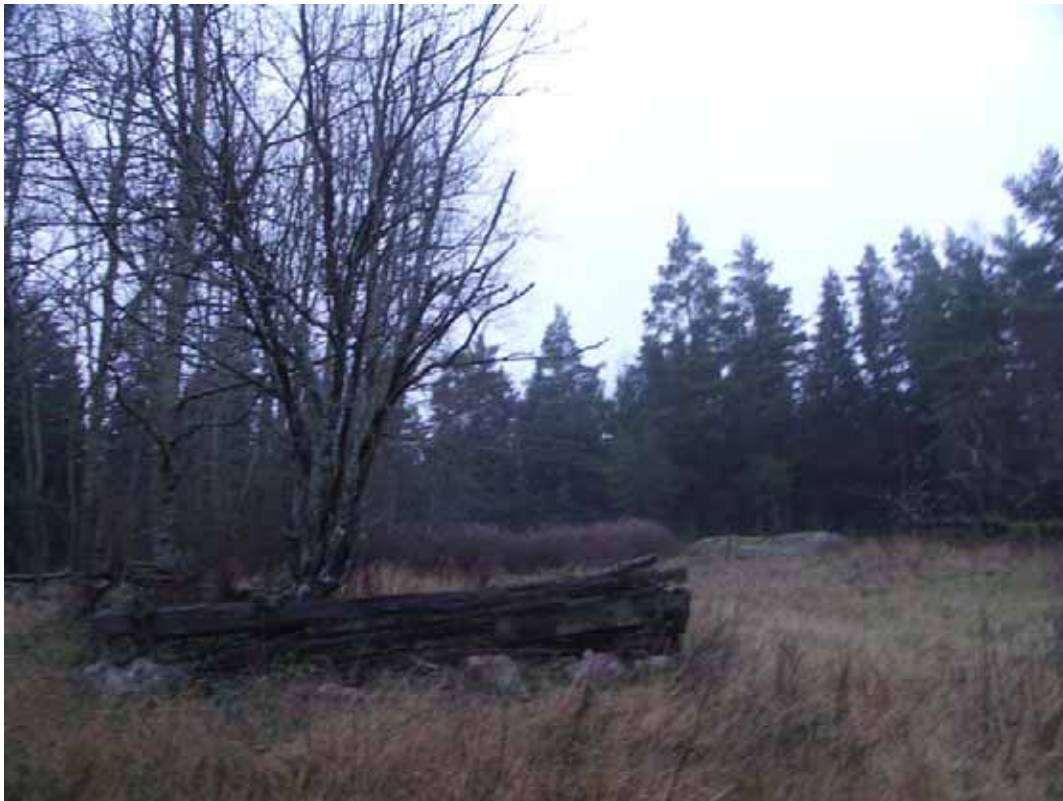
Yksi kohteen uudemmissa rakenteista. ET 2007
