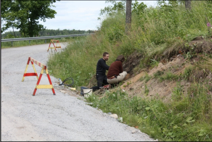
DG1141:76 Työkuva tienleikkauksessa olevan lieden puhdistamisesta kuvattu etelästä kuvaaja Ville-Martti Rohiola
