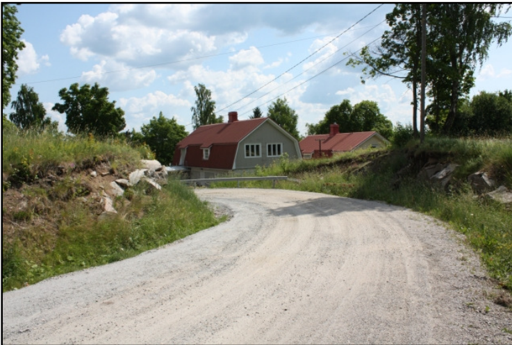
DG1141:14 Huoltotien aiheuttamaa maisemavauriota, taustalla vanha varikkorakennus. kuvattu lännestä kuvaaja Esa Mikkola
