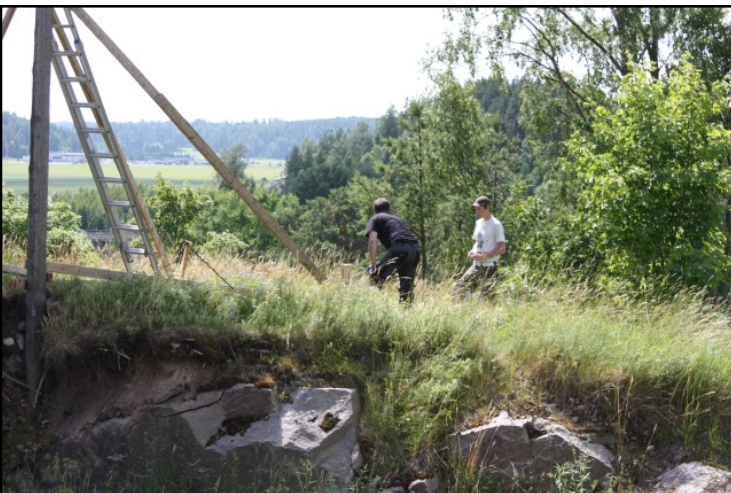
DG1141:81 Työkuva tienleikkauksen eteläpuolella roikkuvan sähkötolpan tukemisesta kuvattu pohjoisesta kuvaaja Esa Mikkola
