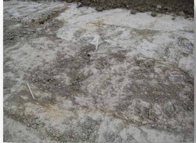
Paineviemäri, kuvattu etelästä.
