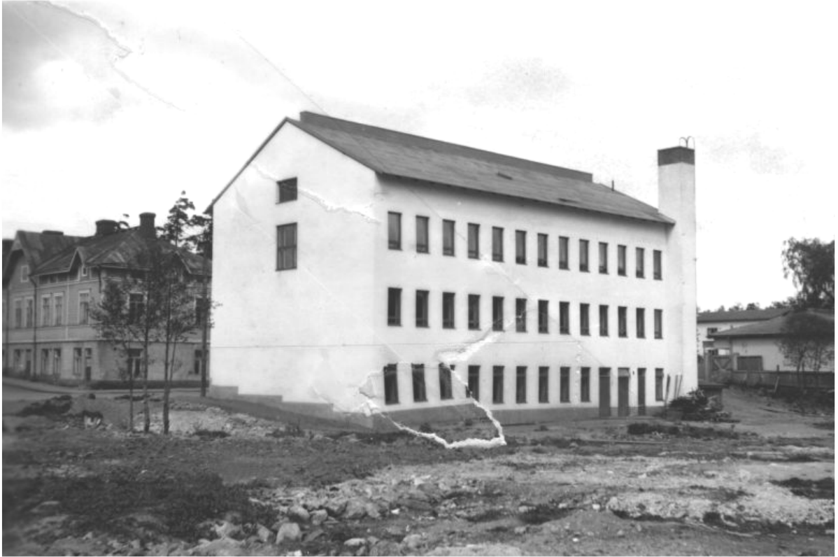
Kuva 4: Kotkan Järjestötalo valmiina. Rakennuksen suunnitteli arkkitehti Erkki Illukka, jonka käsialaa on myös kuvassa Järjestötalon oikealla puolella, Korkeavuorenkatu 11:n tontilla sijaitseva aumakattoinen rakennus. ”Väliaikainen uudisrakennus”, joka purettiin keväällä 2011, valmistui 1940-luvun lopulla, ja siinä toimi pitkään Oy Kotkan Kumikorjaamo ja myöhemmin 1970-1980-luvulla kahvila-ruokala. Samalla tontilla sijaitsee myös toinen 1940-luvun rakennus, jossa toimi kumikorjaamon verstaas. Kuva: Kansan Arkisto (KansA716-1992).
