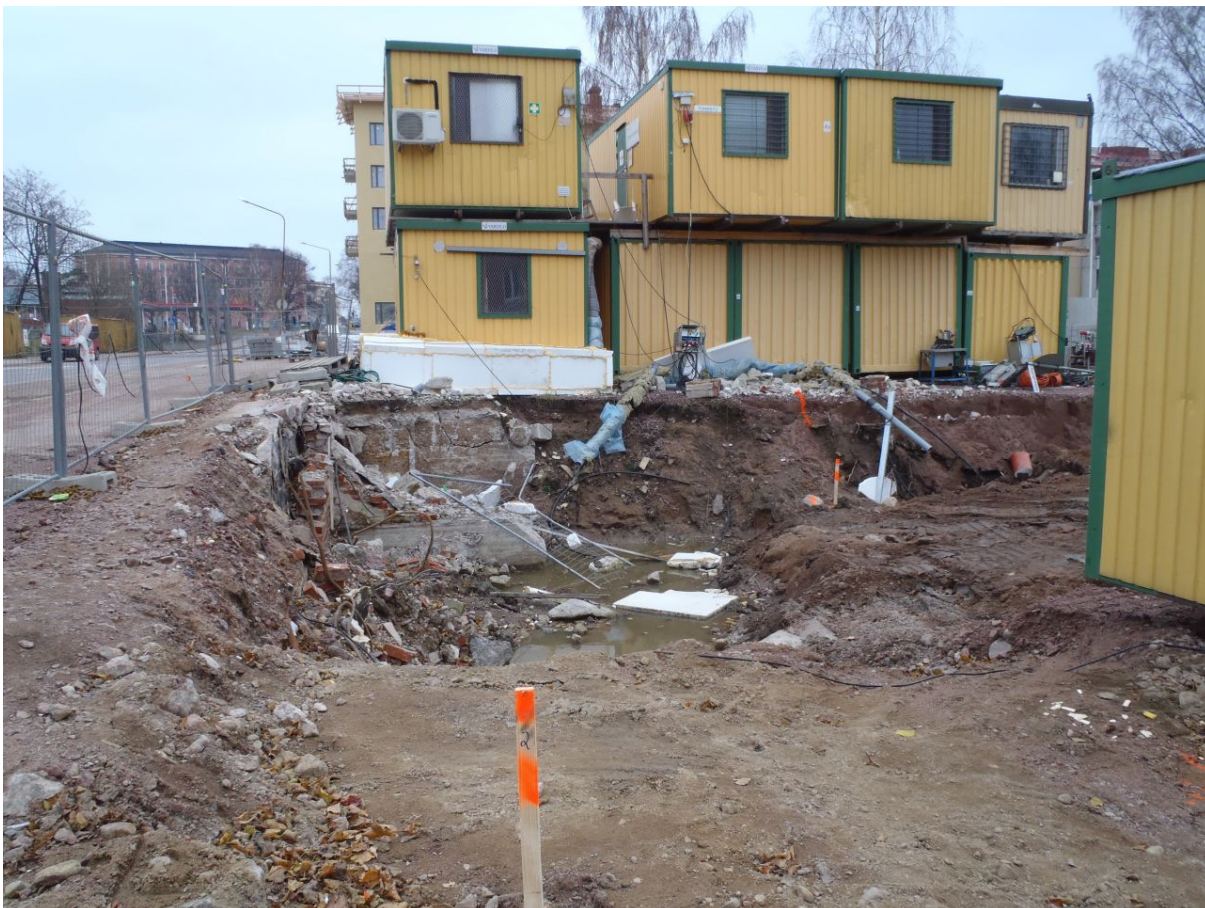
Kuva 27: Korkeavuorenkatu 13 tontin toistaiseksi tutkimaton osa sijaitsee kuvassa taka-alalla näkyvien työmaaparakkien kohdalla. Kuvassa keskellä näkyy Järjestötalon N-nurkan jäännöksiä tiili- ja betonirakenteineen. Kuva on otettu suurin piirtein samalta kohdalta, jossa talkooväki kuvassa 26 raivaa paikalle rakennettavan uuden Järjestötalon aluetta. SW. KyM/M. Kykyri.
