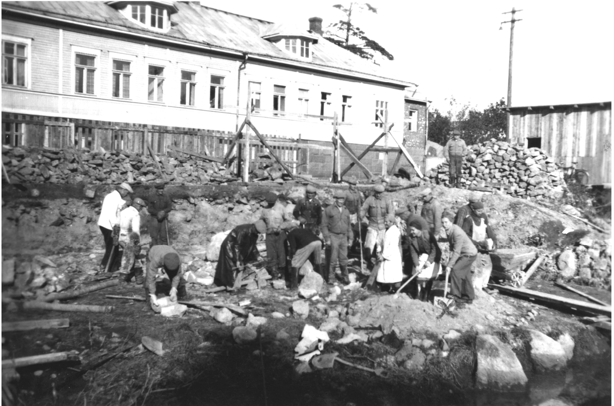
Kuva 26: Järjestötalon rakennuspaikkaa raivataan talkoovoimin 1940-luvun lopulla. Kuvassa näkyvän rakennuksen editse kulkee Korkeavuorenkatu, jonka pohjustuksena oleva ison lohkokiven sekainen täyttömaa on runsaan metrin paksuinen. Talkootyöläiset seisovat silloisella maankamaralla, joka on kostea ja oksien ja sammalen peittämä (kaivauksilla koko tontin alueelta tavattu kerros 7). Kuva-alalla oikealla näkyvä kumpare, jolla yksi talkoolaisista seisoo, on mahdollisesti kalliopaljastuma. Alue, joka vuoden 2011 kaivausten yhteydessä jäi toistaiseksi tutkimatta sijaitsee miehen takana olevan kivikasan ja puuhökkelin paikkeilla. Kuva: Kansan Arkisto (KansA714-1992).
