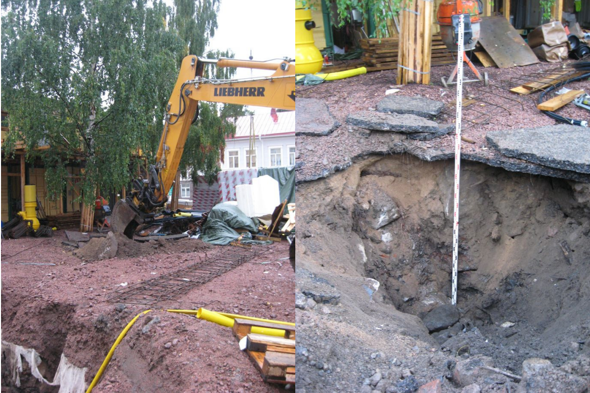
Kuvat 19-20: Vasemmalla koekuoppaa 1 kaivetaan tontin koillissivustalle (E); oikealla kaivannon W-nurkan kerroksia (E). Kuvat: KyM/M. Kykyri.
