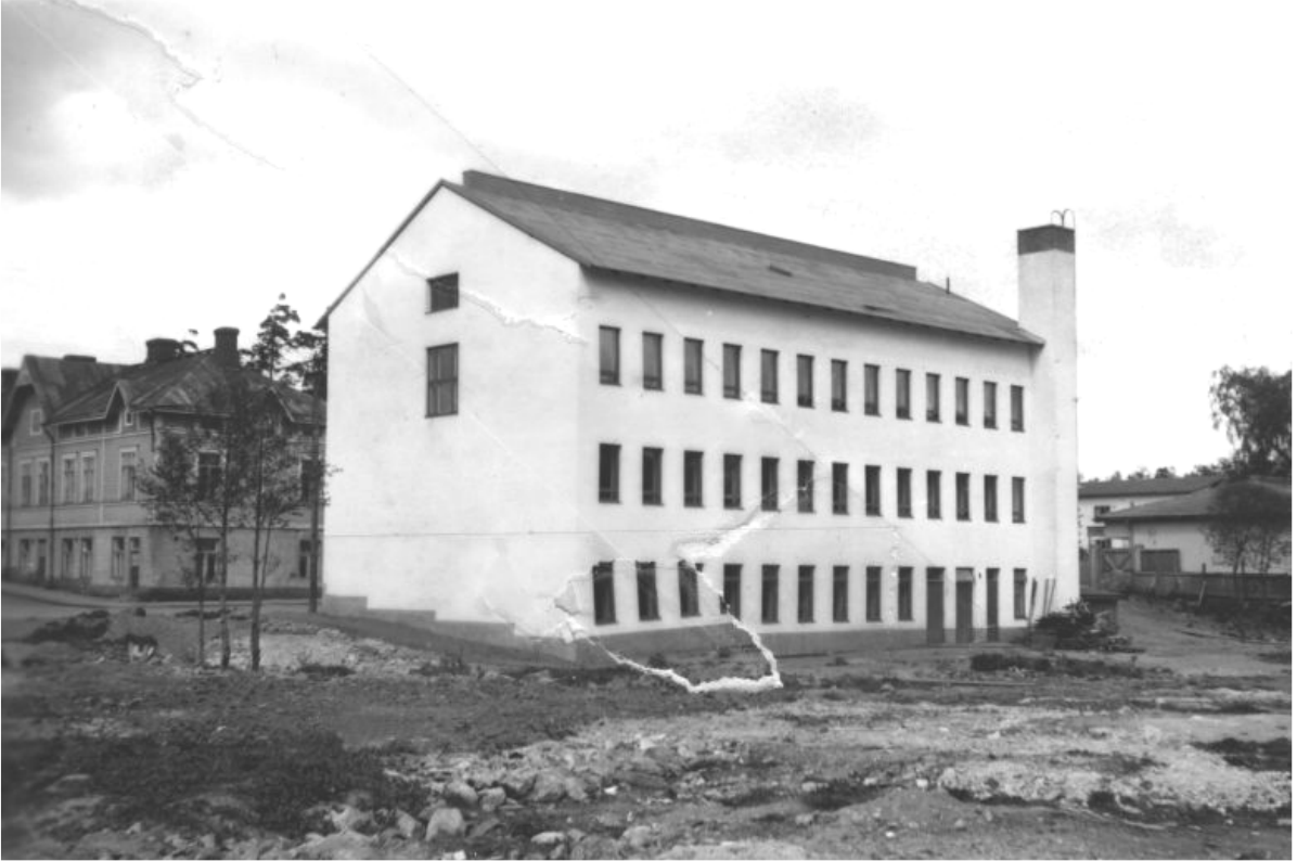
Kuva 4: Kotkan Järjestötalo valmiina. Rakennuksen suunnitteli arkkitehti Erkki Illukka, jonka käsialaa on myös kuvassa Järjestötalon oikealla puolella, Korkeavuorenkatu 11:n tontilla sijaitseva aumakattoinen rakennus. ”Väliaikainen uudisrakennus”, joka purettiin keväällä 2011, valmistui 1940-luvun lopulla, ja siinä toimi pitkään Oy Kotkan Kumikorjaamo ja myöhemmin 1970-1980-luvulla kahvila-ruokala. Samalla tontilla sijaitsee myös toinen 1940-luvun rakennus, jossa toimi kumikorjaamon versta. Kuva: Kansan Arkisto (KansA716-1992).
