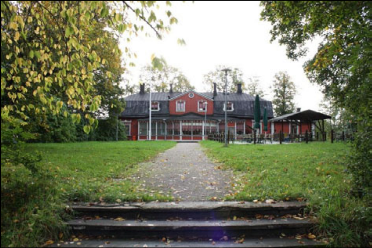
Puotilan kartanon päärakennus nykyasussaan (218053:1) Kuva: Janne Heinonen
