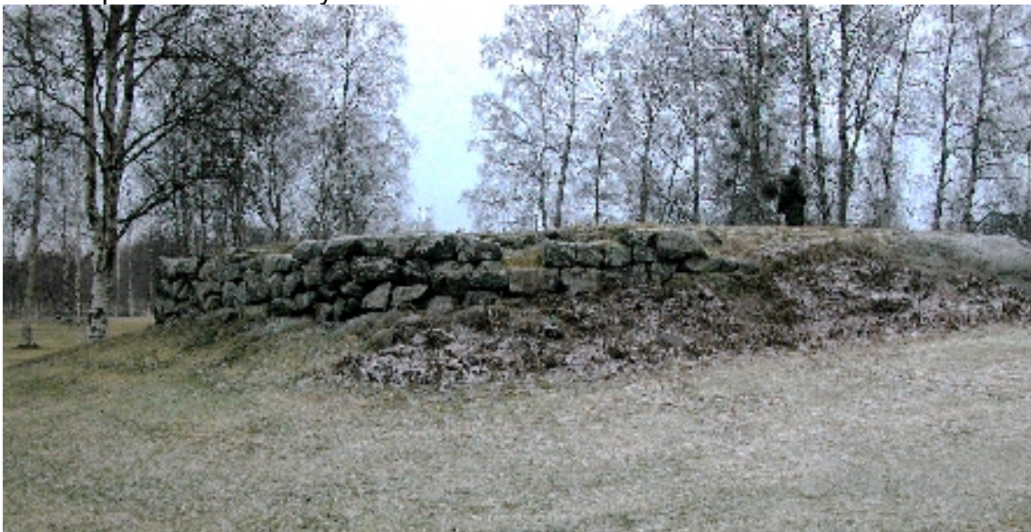
Kuva 39. Rakennuksen perustus etelästä.
