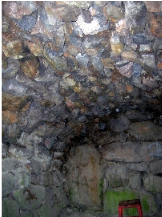
Kuva 37. Kellarin kattoa ja peräseinää
