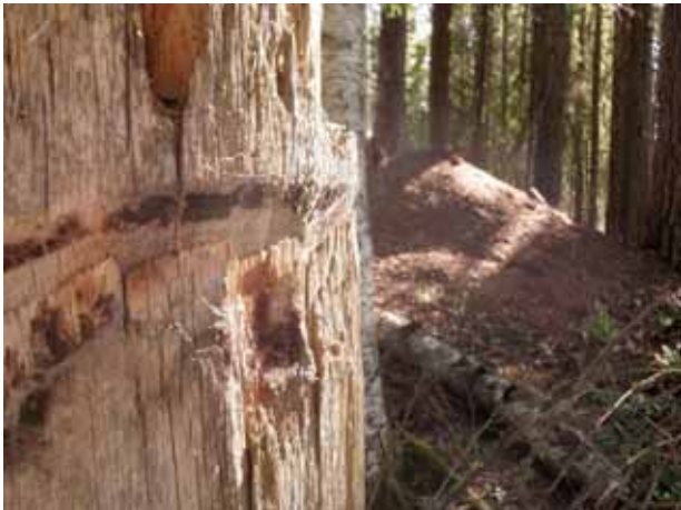
81527: Hirsikangas 1 pykälikköpuu. Lähikuva kelokannon pyällyksestä, jossa palojäljet näkyvät. Lännestä. J. Taivainen 23.6.2010.
