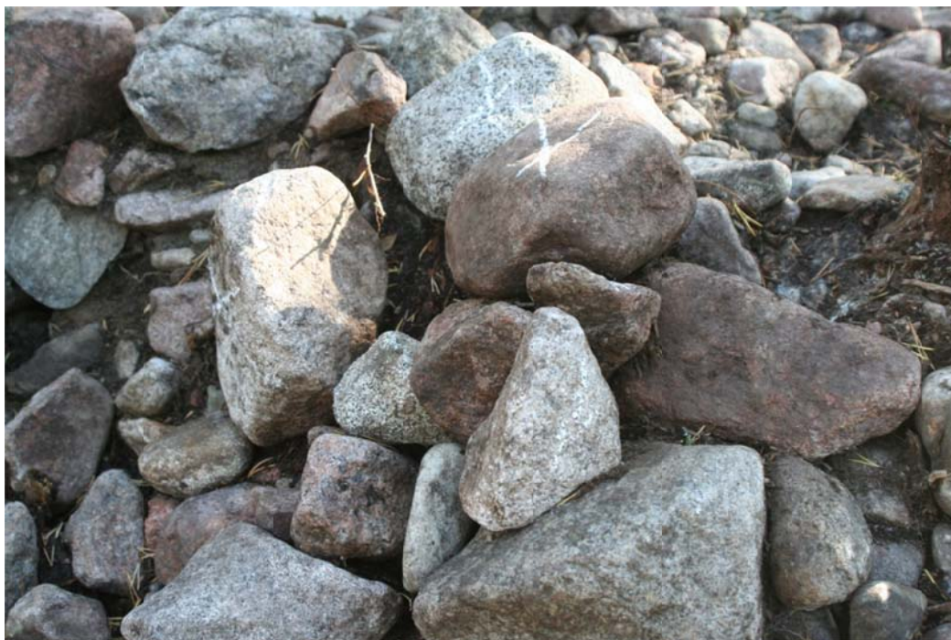
Kuva 9. Latomus 7, rakenteen 2 päätyrakennetta ja kivien "kiilaamista". Kuvattu itäkoilliseen, kuvaaja: Jari-Matti Kuusela
