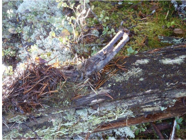
Salvan ja seinärakenteen jäänteitä.
