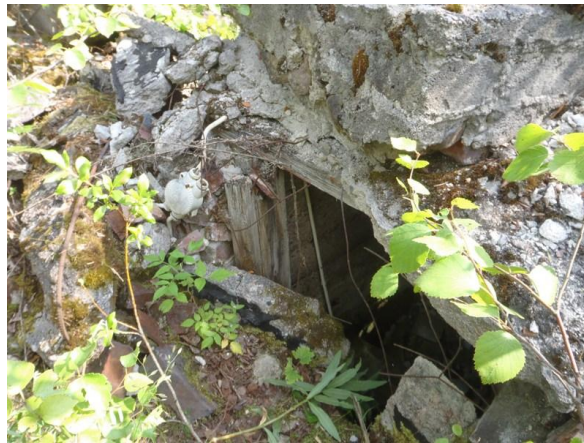
Kellarin oviaukkoa, kuvattu idästä.
