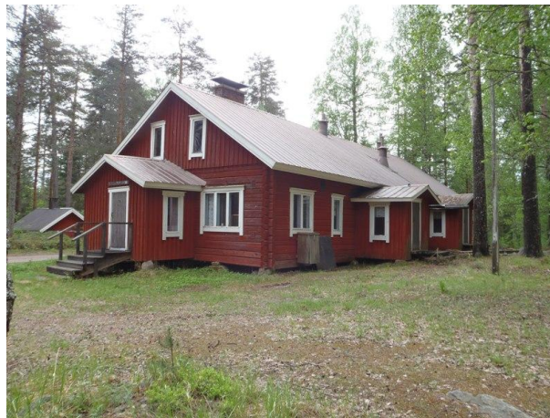
Kämppä, kuvattu koillisesta.
