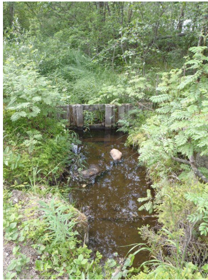
Pienen patorakennelman jäänteet ojassa, kuvattu pohjoisesta.
