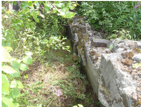
Rakennuksen betoniperustuksia, kuvattu lännestä.
