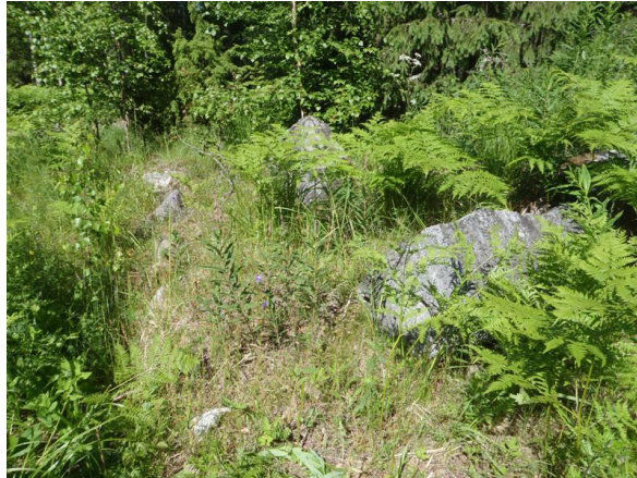
Rakennuksen perustuksia, kuvattu idästä.
