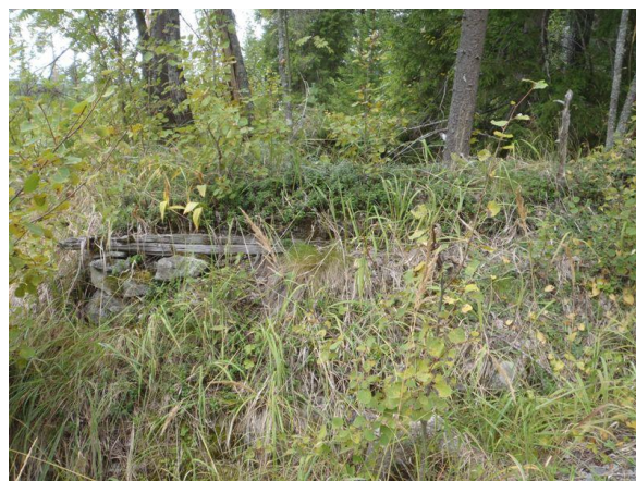
Rakennuksen alahirsiä, kuvattu idästä.
