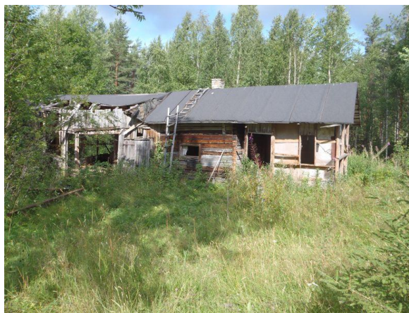
Saunarakennus, kuvattu kaakosta.
