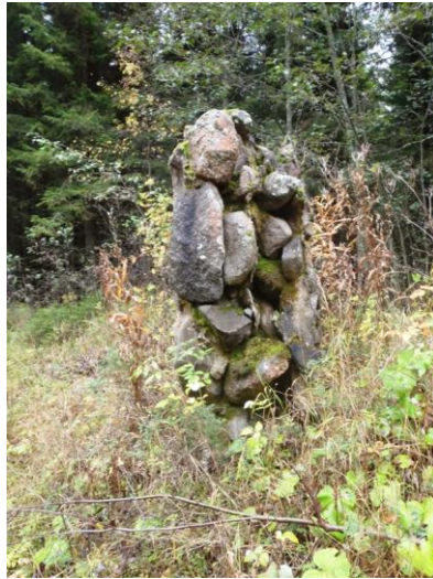
Kivi- ja betonirakenne, kuvattu lännestä.
