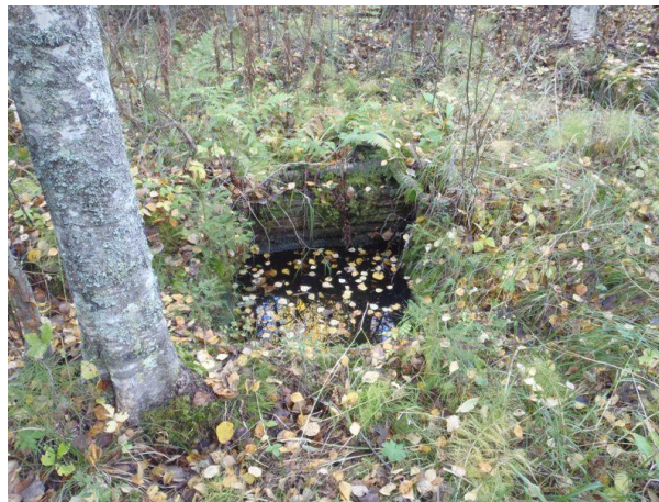
Kaivo, kuvattu kaakosta.
