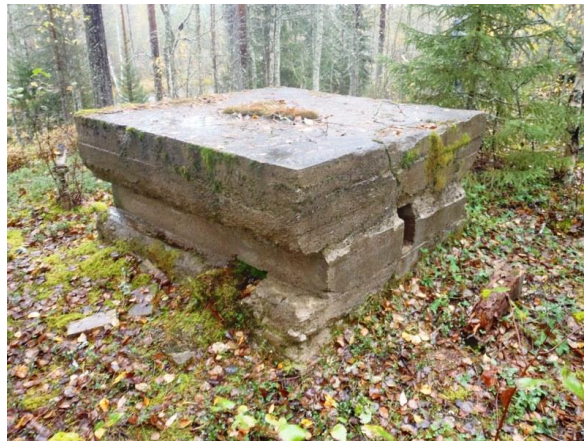
Betonirakenne, kuvattu luoteesta.
