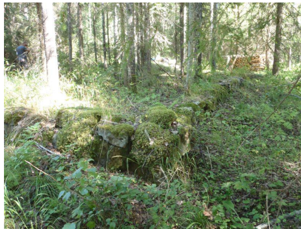
Rakennuksen 1 perustuksia, kuvattu lounaasta.
