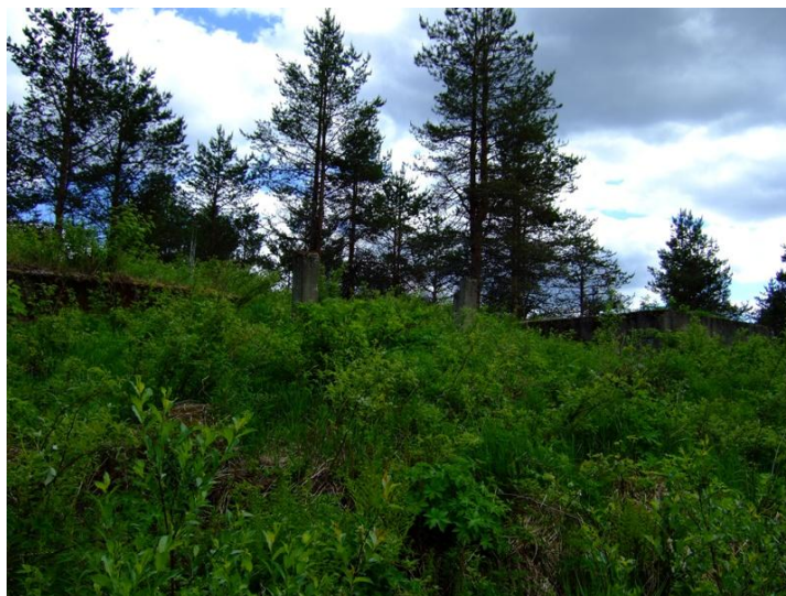
Rakennuksen 2 betoniperusta, kuvattu luoteesta.
