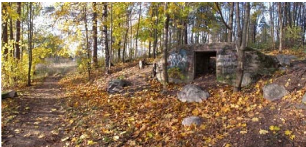
DG2465:1. Finnsbacka. Neuvostoliiton Porkkalan vuokra-ajan betonirakenteita mäen etelärinteellä. Kuvattu kohti NW. Kuva Mu-seovirasto/Mökkönen 21.10. 2011.
