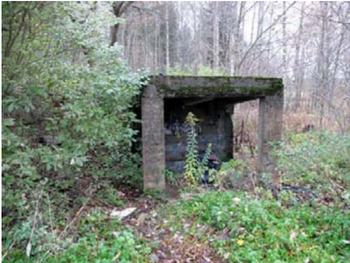
DG2469:1. Lindalissa pienen mäen itälaidalla sijaitseva betoninen ramppi. Kuvattu kohti W. Kuva Museovirasto/Mökkönen 25.10. 2011.
