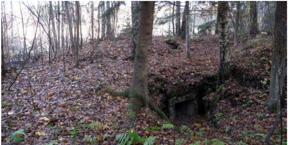
DG2467:1. Jungfrubergetin länsipuolella sijaitseva betoninen asekorsu. Etualalla sisäänkäynti, ja taustalla laella näkyy pyöreä reikä. Kuvattu kohti N. Kuva Museovirasto/Mökkönen 25.10. 2011.
