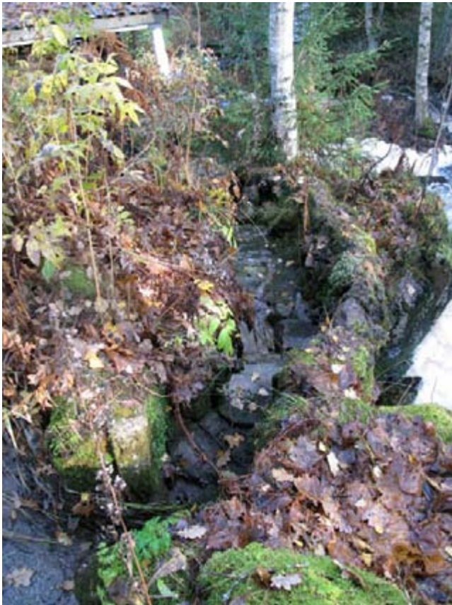
DG2459:2. Ytterkurkin myllyn padolta myllyyn johtaneen vesirännin yläosa. Oikealla (DG) myllynkivi myllynkivijalan länsipuolella. Kuvat Museovirasto/Mökkönen 25.10. 2011.
