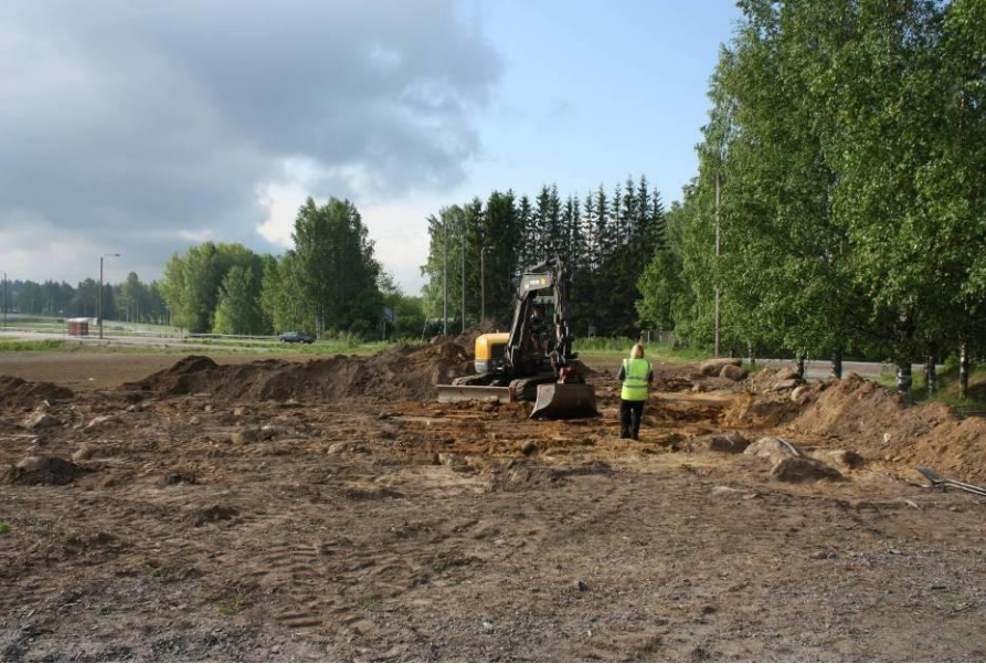
Yleiskuva asuinpaikasta. Kaivinkone alueella 1. Pohjoisesta.
