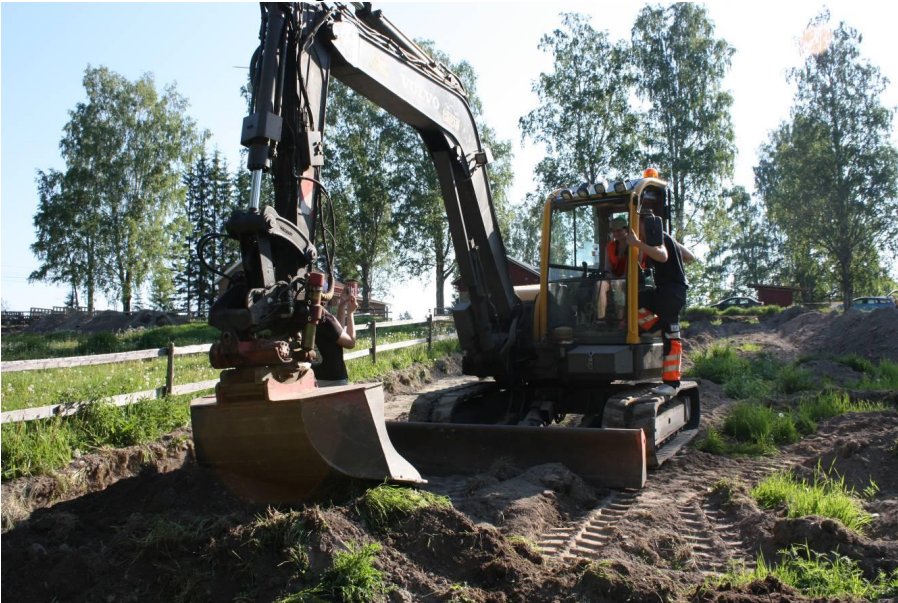
Työkuva. Kaivinkone poistaa maata.
