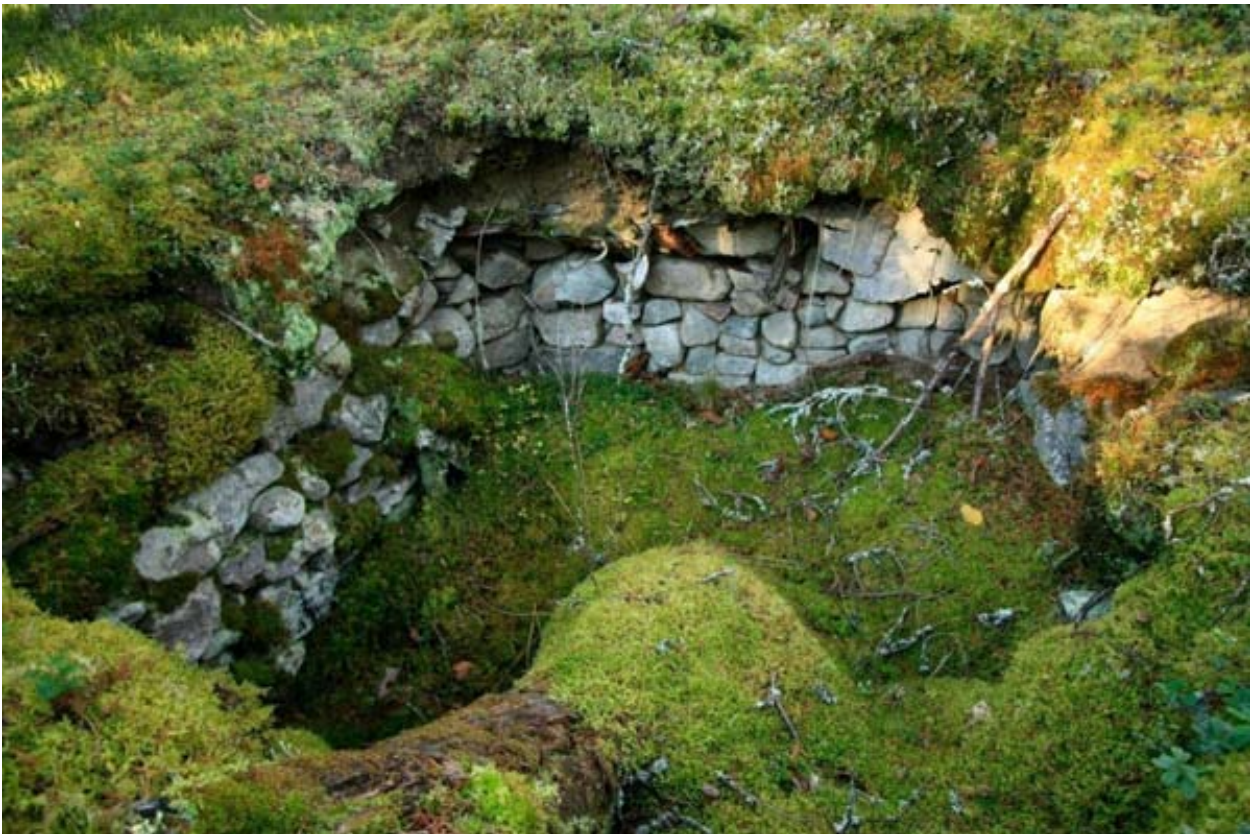
Kuva DG2492:2 Haanela (Eeteni). Kellarin perustus on ladottu luonnonkivistä ja tiivistetty tuohella. Kuva Piritta Häkälä
