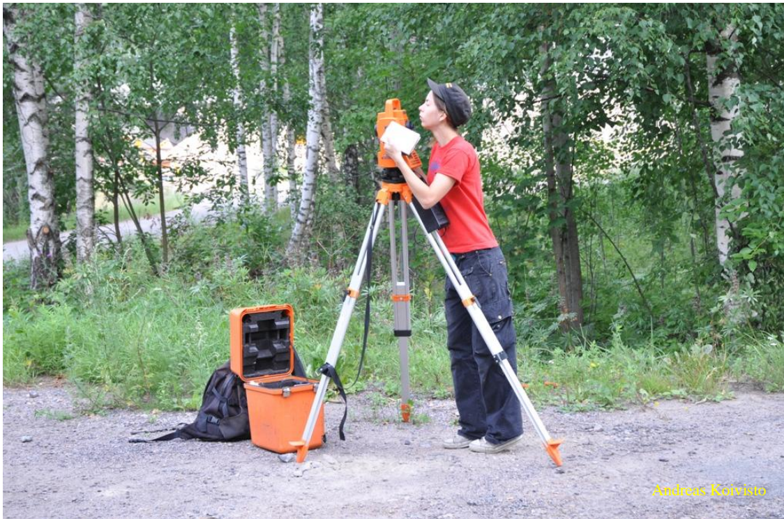
Kuva 3. Koekuopat ja havaitut rakenteet mitattiin paikoilleen takymetrin avulla.
