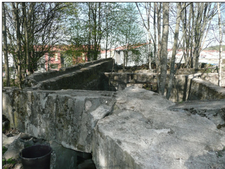
Betonirakenne, bunkkerin tms. jäänne.
