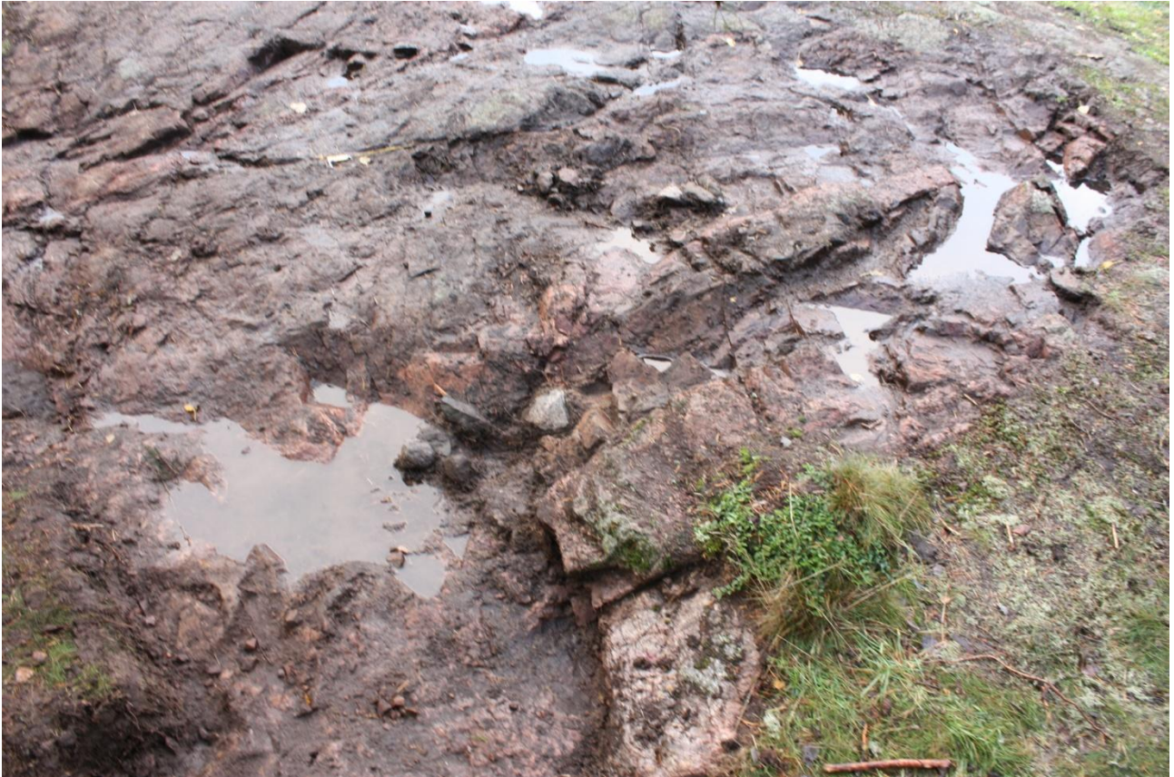
Kiveys A pohjaan kaivettuna. Pohjoisesta.
