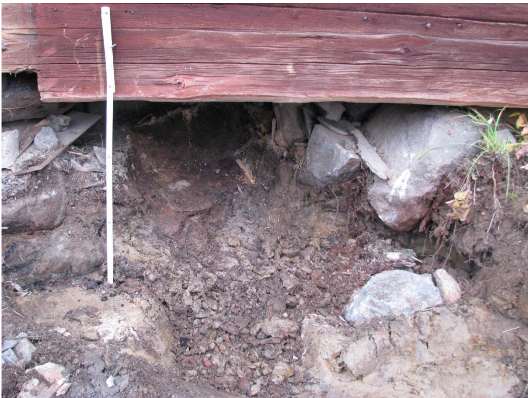
Kuva 21. Kaivinkone poisti osan kivijalkaa kirkon lounaiselta puolelta (oven vierestä). Esille tuli hiiltä ja palojälkiä. Kuva: M. Modarress
