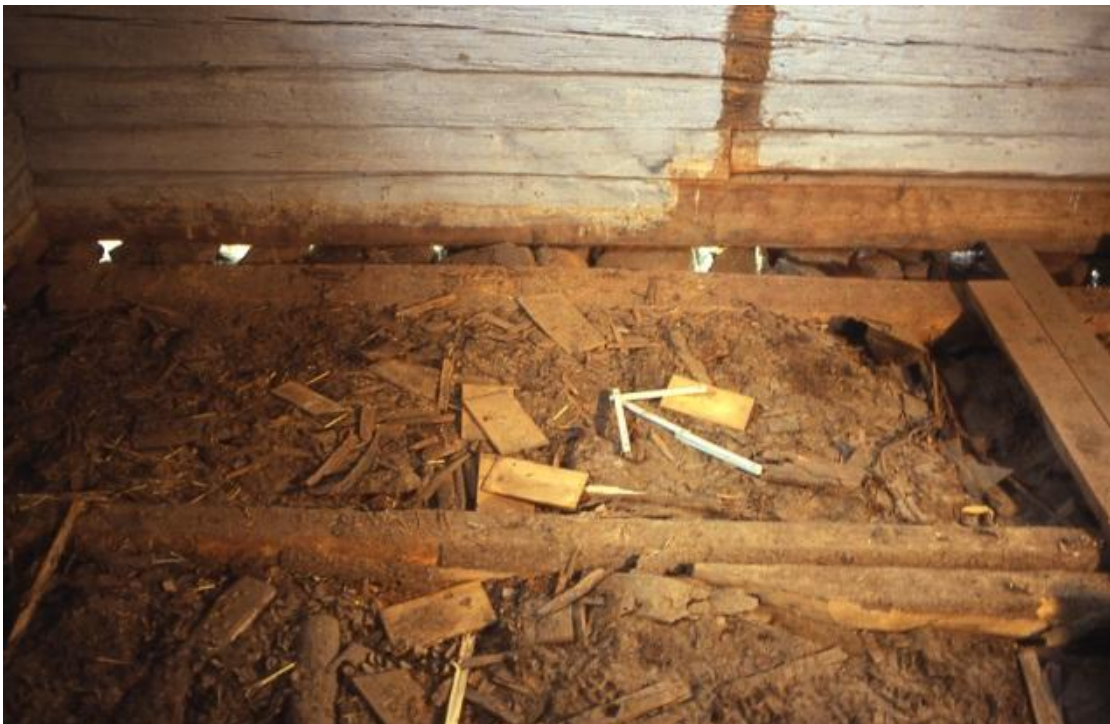
Kuva 11. Pohjoisnurkkaus ennen puhdistusta ja kaivua. Kuva: M. Jormalainen.
