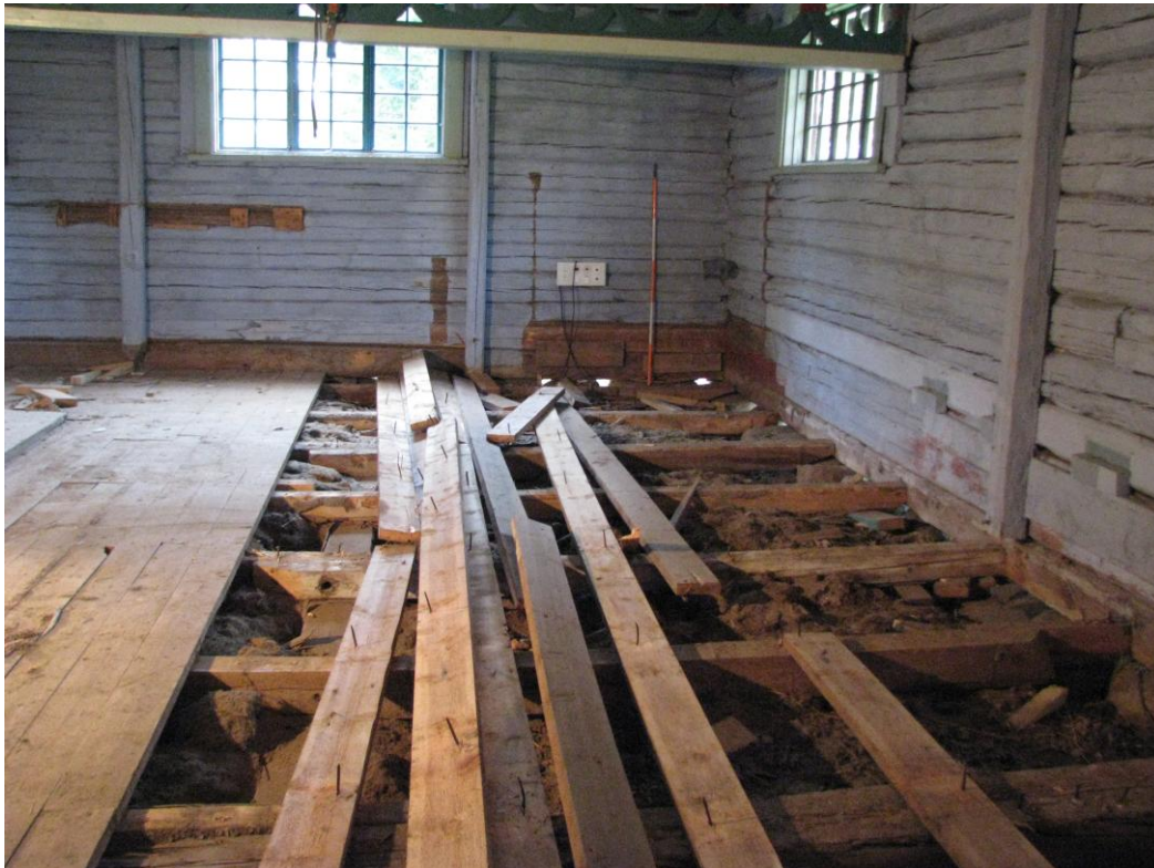
Kuva 3. Lattian purku käynnissä Turkansaaren kirkossa (eteläisellä puolella) kaivausalueiden aukaisua edeltävänä päivänä. Korkeuskiintopiste 1 (14,26 m mpy) näkyvillä kuvan ylänurkassa, mittakepin kohdalla. Kuva: M. Modarress.
