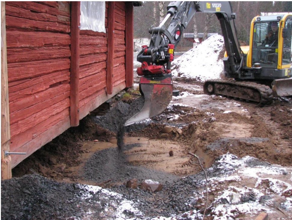
Kuva 25. Kirkon läntisen seinustan perustan korjauksia (valvonta). Kuva: A. Hakonen
