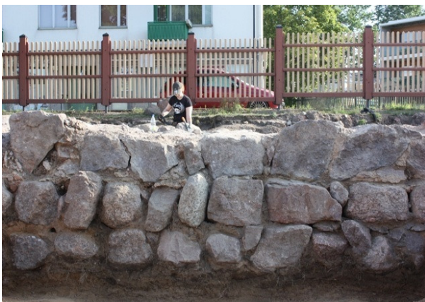
DG2224:157 Esikuntaupseeritalon R23 kaakkoisen väliseinän profiilia. SW-NE. Kuva Katja Vuoristo.
