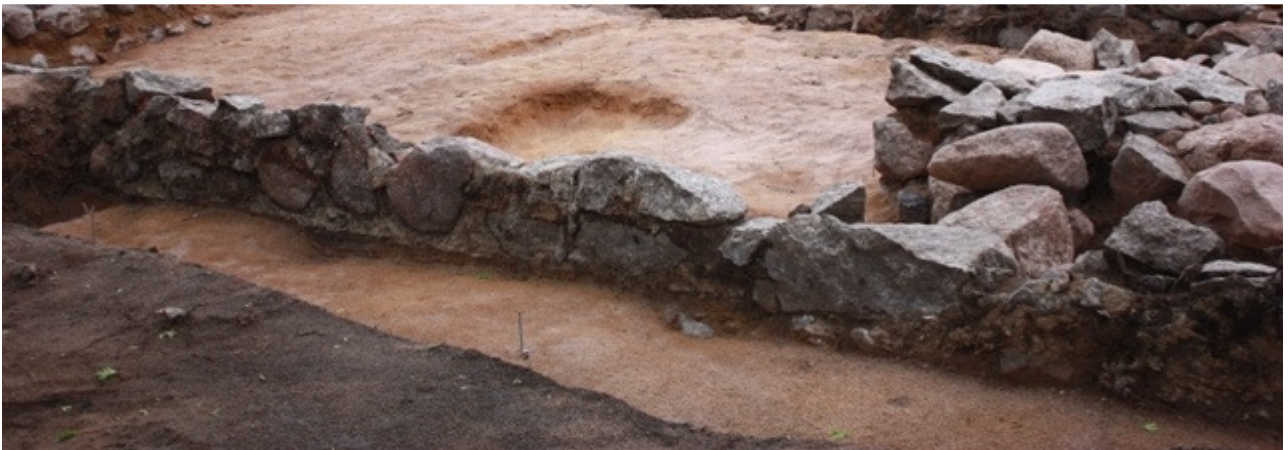
DG2224:34 Kirkon keskiosan kivijalan tasaiseksi muurattu ulkopuoli. Kivijalan vieressä oli merkkejä punamultauksesta. N-S. Kuva Katja Vuoristo.
