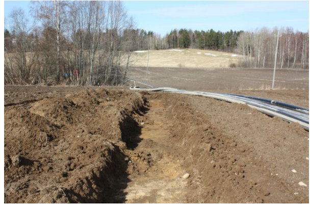
DG2603:5. Hiekkainen koeojan länsipää Naatun talon luoteispuolelle kaivetussa koeojassa. Kuva: Petro Pesonen.
