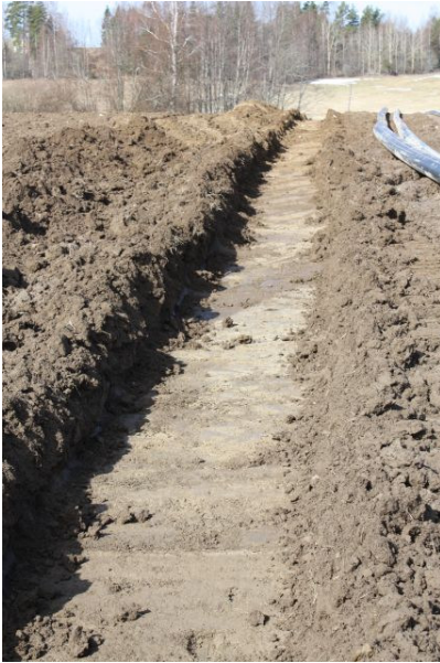
DG2603:4. Naatun talon luoteispuolen pellolle kaivettu koeoja. Kuva: Petro Pesonen.
