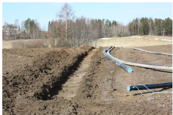
DG2603:3. Naatun talon luoteispuolen pellolle kaivettu koeoja. Kuva: Petro Pesonen
