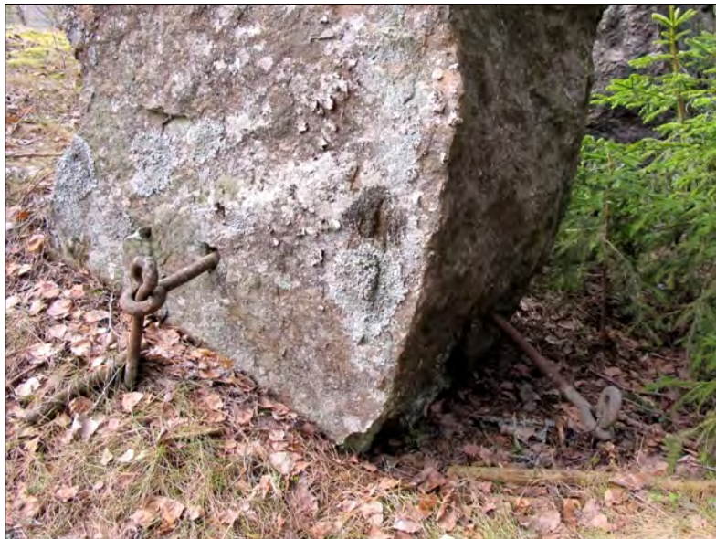
Kuva 42. Estekivi on ankkuroitu kallioon teräslenkeillä Virolahden Koivulassa. Kuva: John Lagerstedt 2010 / Museovirasto 217984:14.
