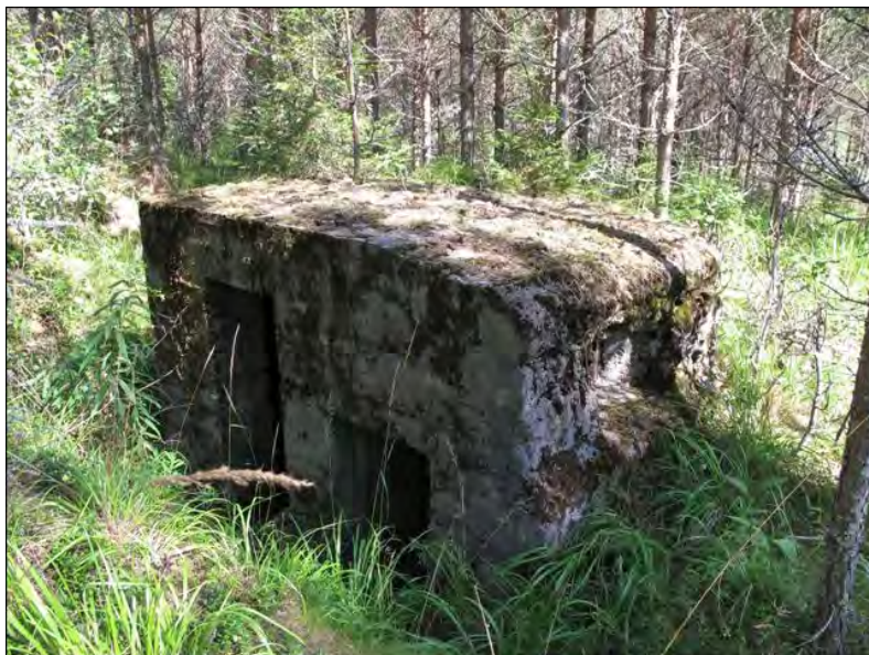
Kuva 77. Miehikkälän Tiaskorvenmäen tuliaseman oikeanpuoleisessa huoneessa on betonin sisään valettu T-37 panssarivaunun teräksinen torni. Ampuma-aukko näkyy rakenteen päätyseinässä. Kuva: John Lagerstedt 2009 / Museovirasto DG2483:1.
