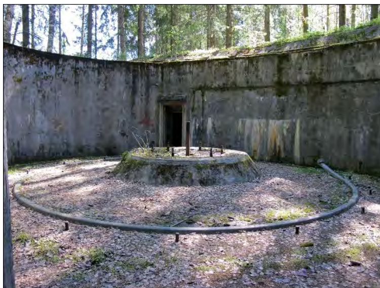
Kuva 39. Lemminkäisen Juvolan patterin tykkiasema nro 4. Kuvassa tykin perusta ja osittain maasta irronnut kehäkisko. Kuva: John Lagerstedt 2010 / Museovirasto 217984:307.
