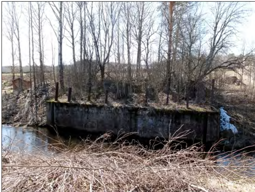
Kuva 30. Ravijoen tulvituspadon uoma tukeva betoniseinä. Kuva: Tiina Mikkonen 2010 / Museovirasto 217984:48.
