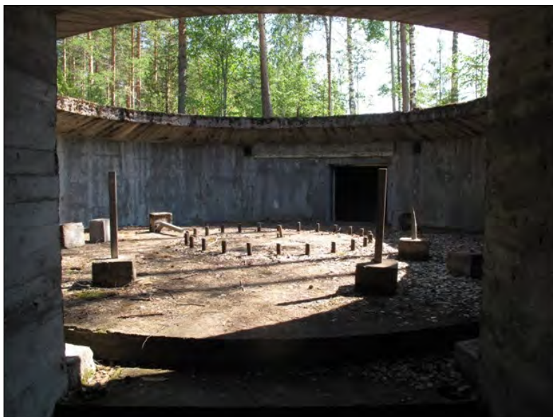
Kuva 37. Lemin Kärmeniemen itäinen tykkiasema. Taustalla ovi tykkiaseman komentosuojaan. Kuva: Tiina Mikkanen 2011 / Museovirasto DG2534:2.
