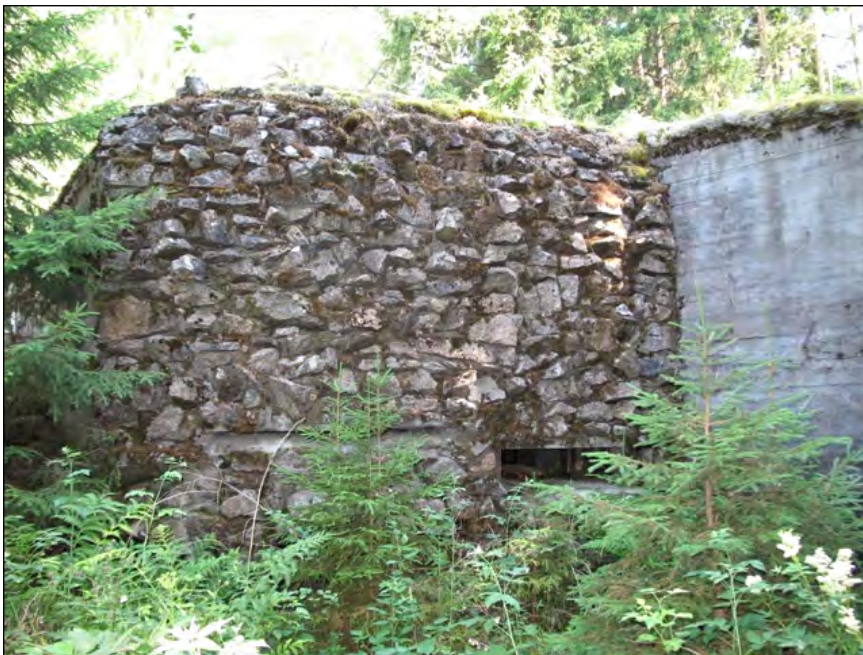
Kuva 13. Virolahden Niemenkankaan konekiväärinkorsiun nro 33 aseseinä on naamioitu kivimuurauksella. Oikealla osa betonisesta siipimuurista, keskellä konekiväärin ampuma-aukko. Vasemmalla, matalien kuusien takana erottuu kapeana rakona asekkammion tähystysaukko. Kuva: Tiina Mikkanen 2010 / Museovirasto 217984:168.
