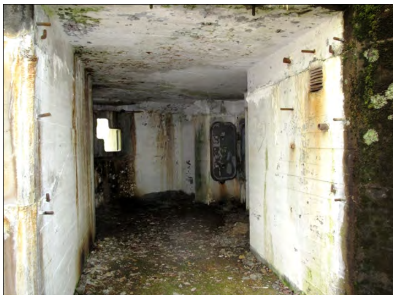
Kuva 73 Korsun 318 tykin ampumakammio on rakenteeltaan poikkeuksellinen Miehikkälän Salpalinjamuseon kohteessa. Vasemmalla tykin ampuma-aukko. Asekammio on takaa avoin. Kuva: Tiina Mikkanen 2011 / Museovirasto DG2444:3.
