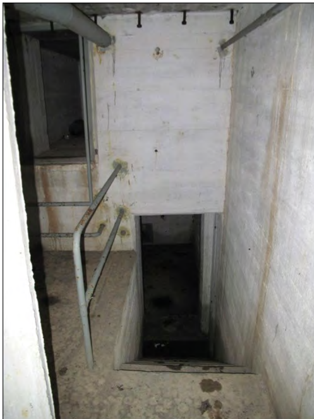
Kuva 106. Korsun nro 6-7 sisätiloja. Alakerrassa on konekiväärin asekkammio ja vasemmalla ylhäällä sisäänkäynti panssaritorjuntakiväärin asekkammioon. Puumala, Puumalansalmen linnoitteet 3. Kuva: Markus Kankkunen 2010 / Museovirasto 217984:317.
