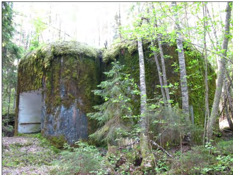
Kuva 93. Korsu nro 6/R on jäänyt peittämättömäksi suojakiveyksellä ja maalla. Sisäänkäynnissä on panssaritorjuntatykin suojatila. Kuva: John Lagerstedt 2010 / Museovirasto 217984:260.
