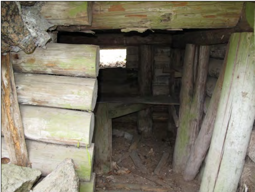
Kuva 7. Hirsistä ja betonista rakennettu konekivääripesäke Luumäen Tahvolassa. Kuva: Tiina Mikkanen 2010 / Museovirasto 217984:235.
