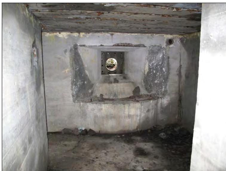
Kuva 102. Tyypillinen panssaritorjuntatykin asekammiio ja ampuma-aukko korsussa nro 1. Lappeenran-ta, Naurissaari Kuva: Tiina Mikkonen 2011 / MuseovirastoDG2524:1.
