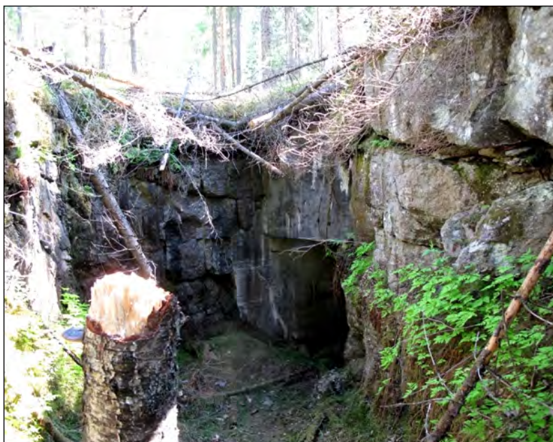
Kuva 75. Majoituskorsun nro 412 sisäänkäynti, jossa on betonikatossa panssaritorjuntatykin suojatila. Kuva: Tiina Mikkonen 2011 / MuseovirastoDG2478:1.
