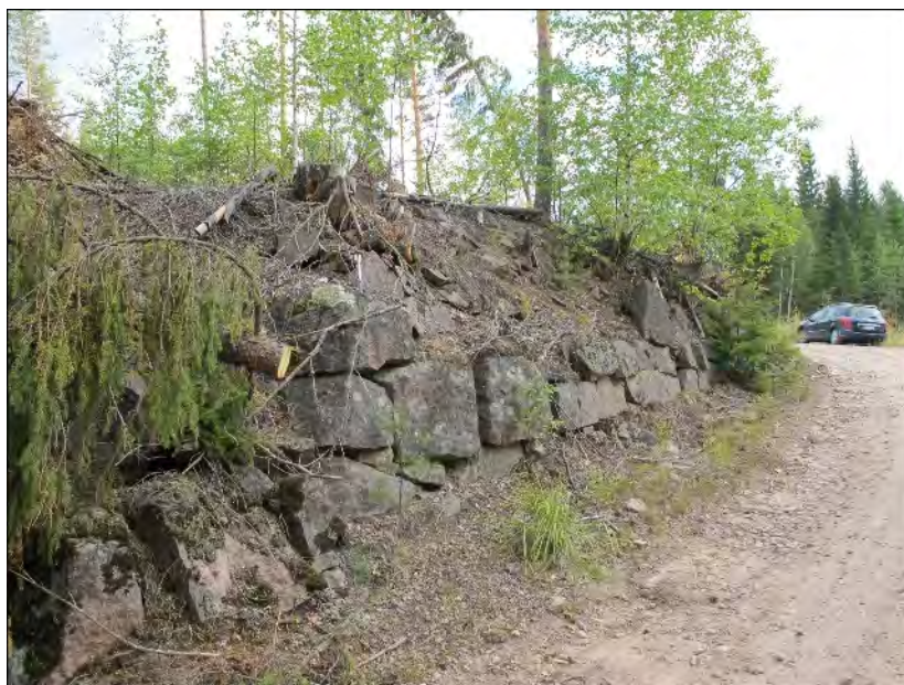
Kuva 109. Panssarivaunun estekivimuri Punkaharjun Sikolamminmäellä. Kuva: John Lagerstedt 2010 / Museovirasto 217984:331.
