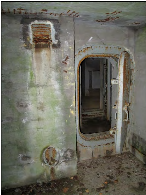
Kuva 80. Korsun nro 303-304 sisäänkäynti Luumäen Suntiossa. Oven vasemman puoleisen seinän alaosassa on käsikranaatin pudotusputken aukko. Kuva: Tiina Mikkanen 2011 / MuseovirastoDG2553:1.
