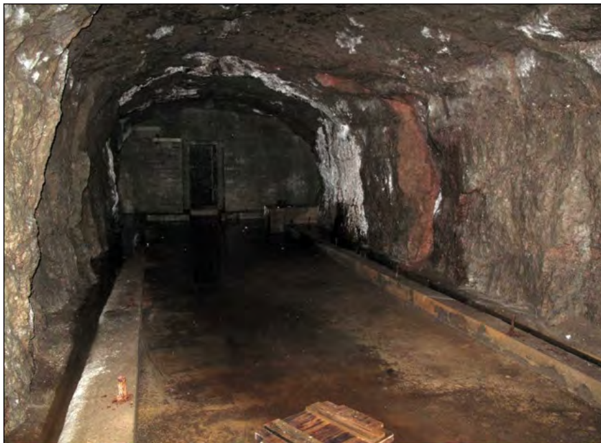
Kuva 25. Kallioon louhittu majoitustunneli nro 41 Virolahden Ahdassalmessa. Betonilattian reunassa on matala sokkeli tunneliin tarvittaessa rakennettavaa puuparakkia varten. Kuva: Tiina Mikkanen 2010 / Museovirasto 217984:3.
