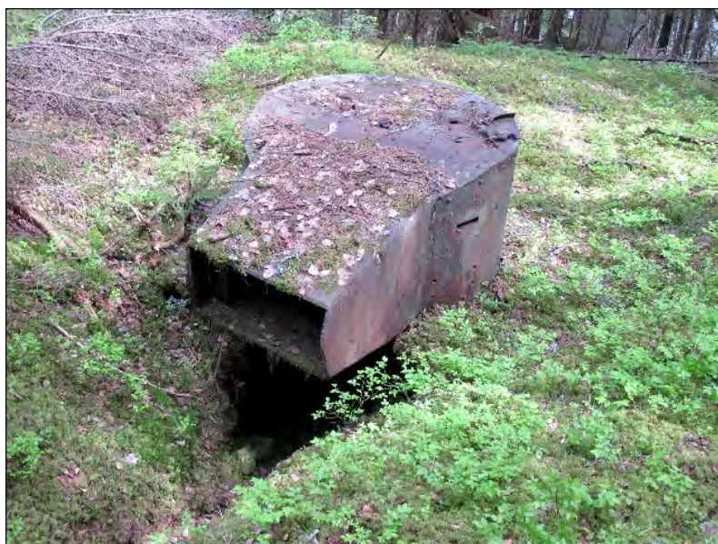
Kuva 94. BT-2 panssarivaunun tornista tehty teräspesäke Lappeenrannan Hautasenvuoren kohteessa. Kuva: John Lagerstedt 2010 / Museovirasto217984:263.
