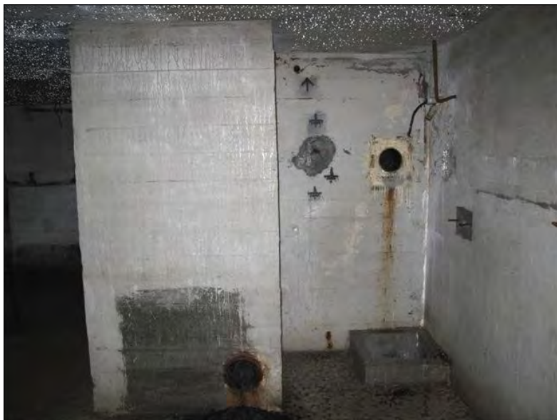
Kuva 76. Korsun nro 368 majoitustilassa on seinässä antennin läpivienti (merkitty nuoli-symbolilla) sekä radiolaitteiston maadoitusliitos, (merkitty \perp -symboleilla). Vasemman seinän maalaamattomassa kohdassa on ollut liesi ja oikeassa nurkassa matalareunainen juomavesikaivo. Kuva: Tiina Mikkanen 2011 / Museovirasto DG2479:1.
