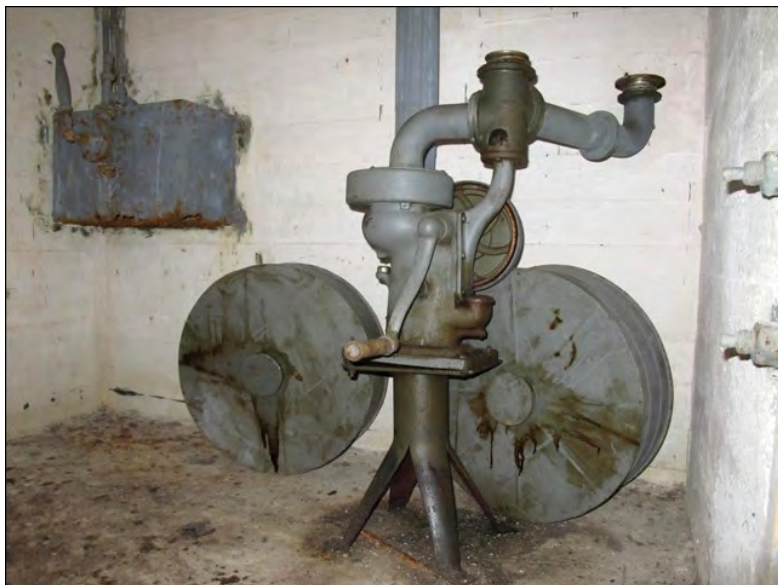
Kuva 48. Ilmanvaihtokoje ja kaasusuodattimet konekiväärin kupupesäkkeessä nro 273a Virolahden Vahtivuorella. Vasemmalla konekiväärin jäähdytysvesisäiliö ja pumppu. Kuva: John Lagerstedt 2010 / Museovirasto 217984:56.
