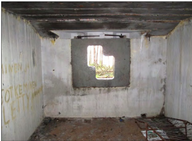
Kuva 101. Korsun 907a tykin aseammio on poikkeuksellinen rakenteeltaan. Ampuma-aukon ulkopuolella on teräsluukut, jotka voidaan kääntää sisältäkäsien aukon eteen sen yläpuolella olevista kahvoista. Lappeenranta, Ruohosaari. Kuva: Tiina Mikkanen 2010 / Museovirasto DG2500:4.
