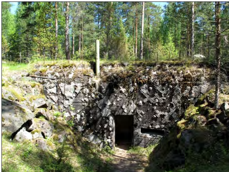
Kuva 88 Korsun C10 ulkoseinään kiinnitettyyn metalliverkkoon levitetty naamiorappaus on pudonnut suurimmaksi osaksi pois. Kuva korsun sisäänkäynnin suuntaan. Oviaukon vierellä on korsun lähitorjuntaan tarkoitettu ampuma-aukko. Kuva: Tiina Mikkanen 2010 / Museovirasto 217984:227.
