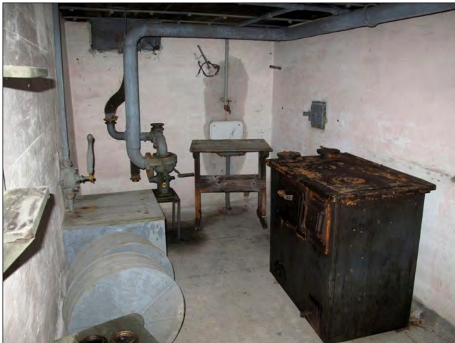
Kuva 43. Virolahden Kokkolan korsu 48 on kalustettu. Kuvassa vasemmalta: ilmanvaihtokojeen kaasusuodattimet, kaivo ja pumppu, ilmanvaihtokoje, pöydän takana kaatoallas, liesi. Kuva: Tiina Mikkanen 2010 / Museovirasto. 217984:20
