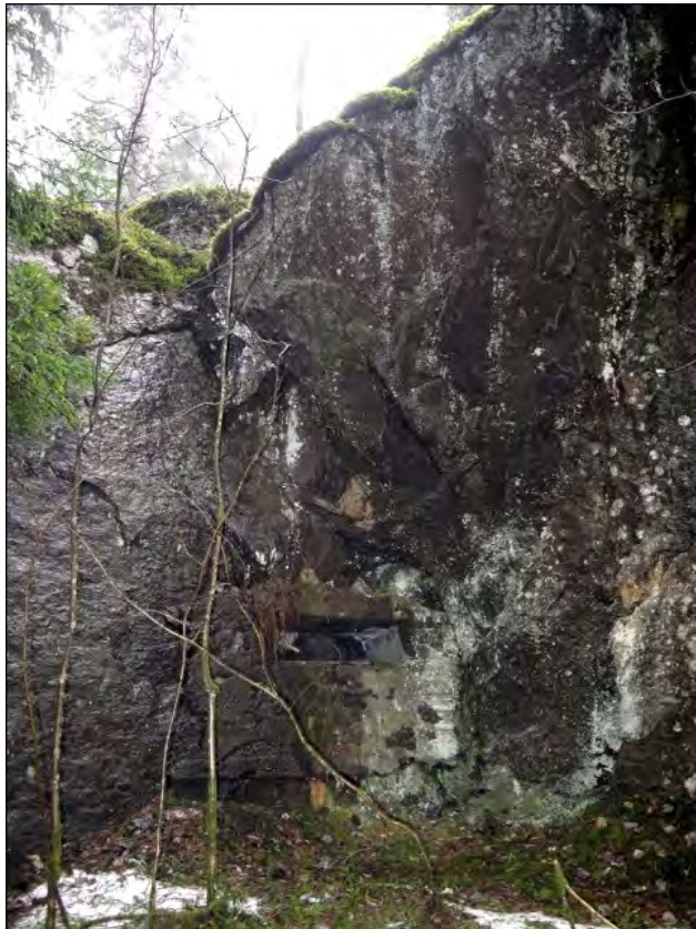
Kuva 45. Estekivilouhoksen nurkkaan on valettu betoninen valeampuma-aukko Virolahden Ventonvuorella. Kuva: Tiina Mikkanen 2010 / Museovirasto 217984:27.
