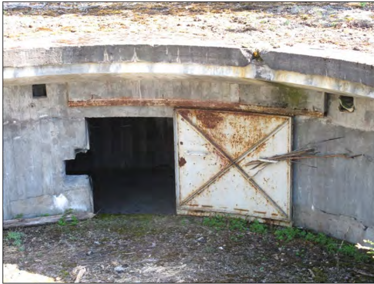
Kuva 40. Virolahden Klamilan tykkipatterin itäisemmän tykkiaseman komentosuojan teräksinen liukuovi on vielä paikoillaan. Kuva: Tiina Mikkanen 2010 / Museovirasto DG2382:3.
