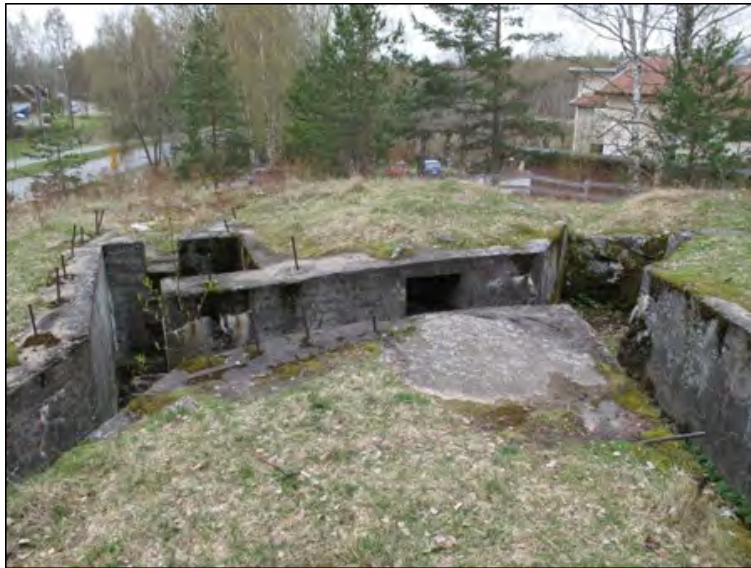
Kuva 103. Betonilla vahvistettua taisteluhautaa ja ampumatarvikekomero Lappeenrannan Voisalmen korsun nro 5 vieressä. Vasemmalla betoninen tuliasema ja oikealla kallioon louhittu ampumasyvännys. Kuva: Tiina Mikkanen 2010 / Museovirasto217984:302.
