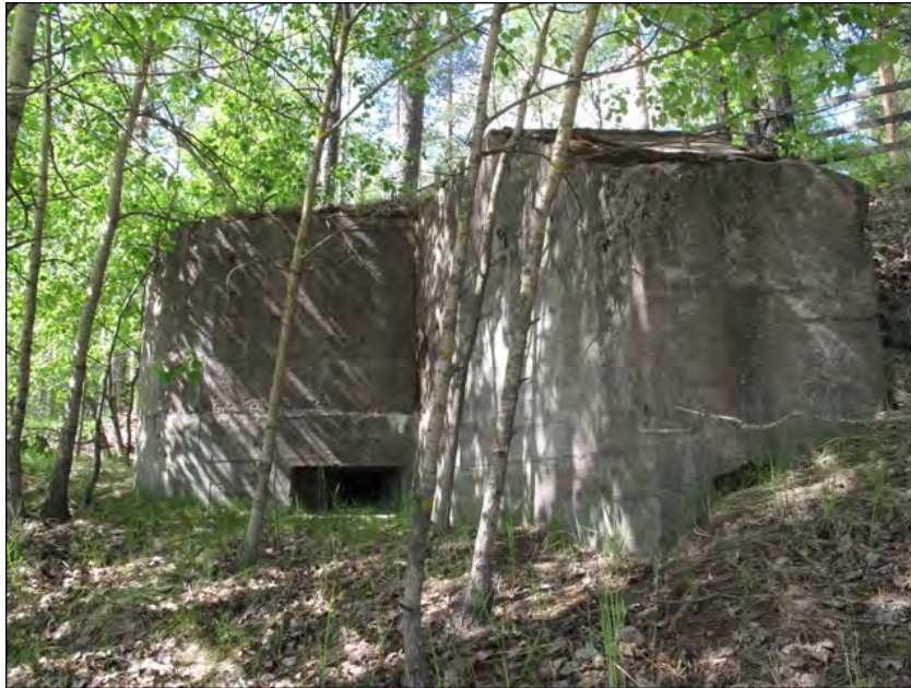
Kuva 19. Teräsbetoninen, neljännen lujuusluokan konekivääripesäke nro 602 Luumäen Likolahdessa. Kuva: Tiina Mikkanen 2010 / Museovirasto 217984:246.
