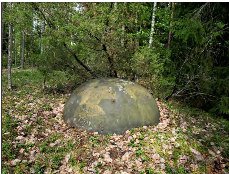
Kuva 68. Vuoden 1940 mallisessa tähystyskuvussa on jäljellä mahdollisesti alkuperäinen naamiomaalaus. Miehikkälä, Riihimäki, korsu 307. Kuva: John Lagerstedt 2011 / Museovirasto DG2425:1.
