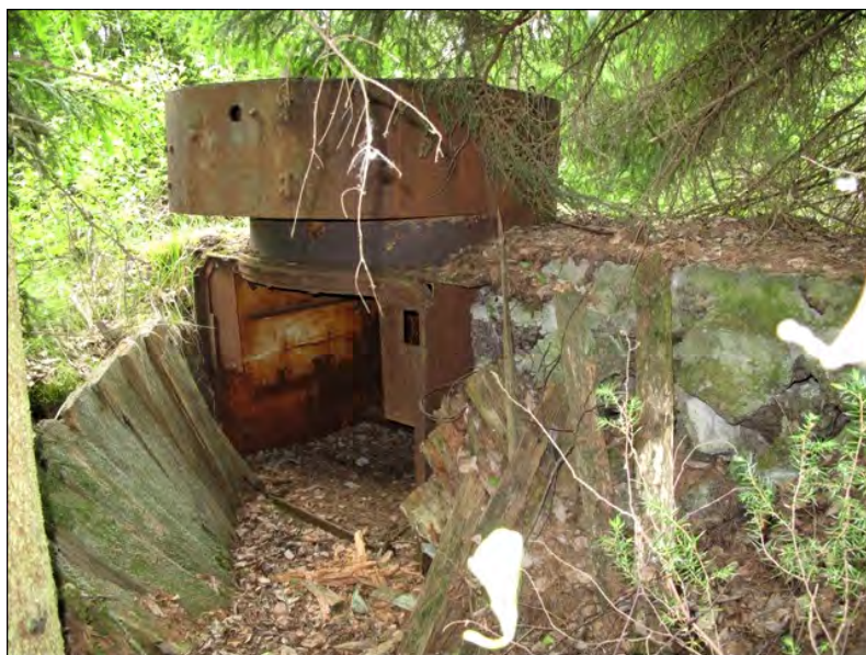
Kuva 89. BT-5 panssarivaunusta rakekennetun teräspesäkkeen nro 1337 sisäänkäynnin yhteydessä on vielä jäljellä puurakenteita. Kuva: Tiina Mikkanen 2010 / Museovirasto 217984:212.
