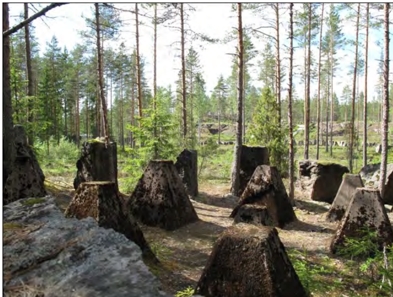
Kuva 72. Miehikkälän Salpalinja-museon alueella on panssarivaunun esteessä kokeiltu betonisärmiöitä. Kuva: Tiina Mikkonen 2011 / Museovirasto DG2444:1.
