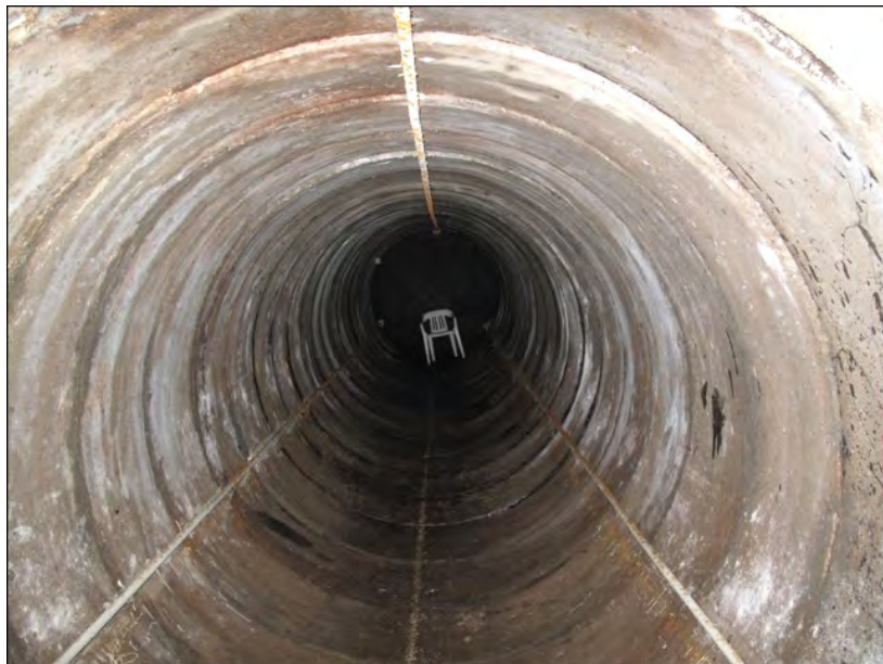
Kuva 86. Korsu nro 3003 on koottu betonisista rengaselementeistä Luumäen Huomolassa. Kuva: Tiina Mikkonen 2010 / Museovirasto 217984:243.
