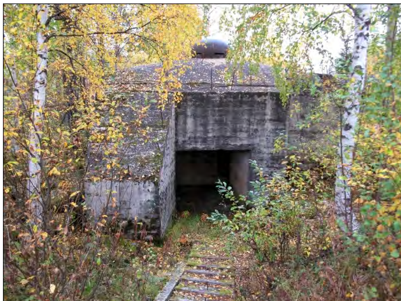
Kuva 133. Majoituskorsun nro 21 sisäänkäynnin yhteydessä on panssaritorjuntatykin suojatila. Korsun katolla on tähystyskupu mallia 1940. Kemijärvi, Joutsijärvi. Kuva: Markus Kankkunen 2010 / Museovirasto 217984:384.
