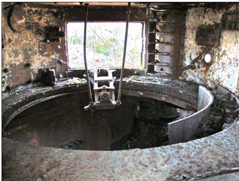
Kuva 47. Sisäkuva BT-5 panssarivaunun tornista tehdystä teräspesäkkeestä Virolahden Riihikorven kohteessa. Kuva: John Lagerstedt 2010 / Museovirasto 217984:41.
