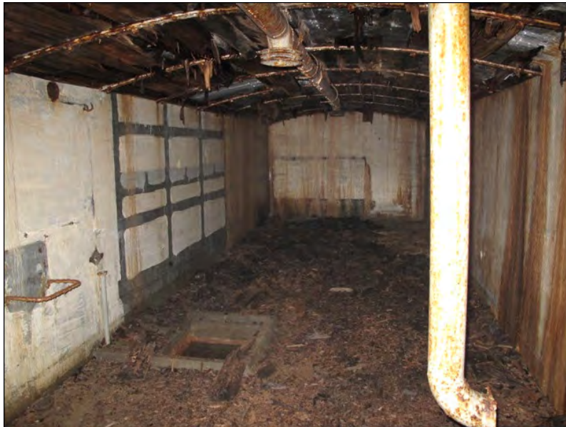
Kuva 71 Korsun 329 majoitustilan lattiassa on matalareunainen juomavesikaivo. Seinillä näkyvät maakuulavereiden sijaintipaikat maalaamattomina alueina. Miehikkälä, Laajanpohja. Kuva: Tiina Mikkanen 2011 / Museovirasto DG2427:2.
