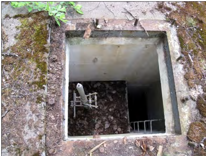
Kuva 21. Tulenjohtokorsun nro 1320 avoin tähystyskuilu ja todennäköisesti haarakaukoputken jalusta Luumäen Huomolassa. Kuva: Tiina Mikkanen 2010 / Museovirasto 217984:216.
