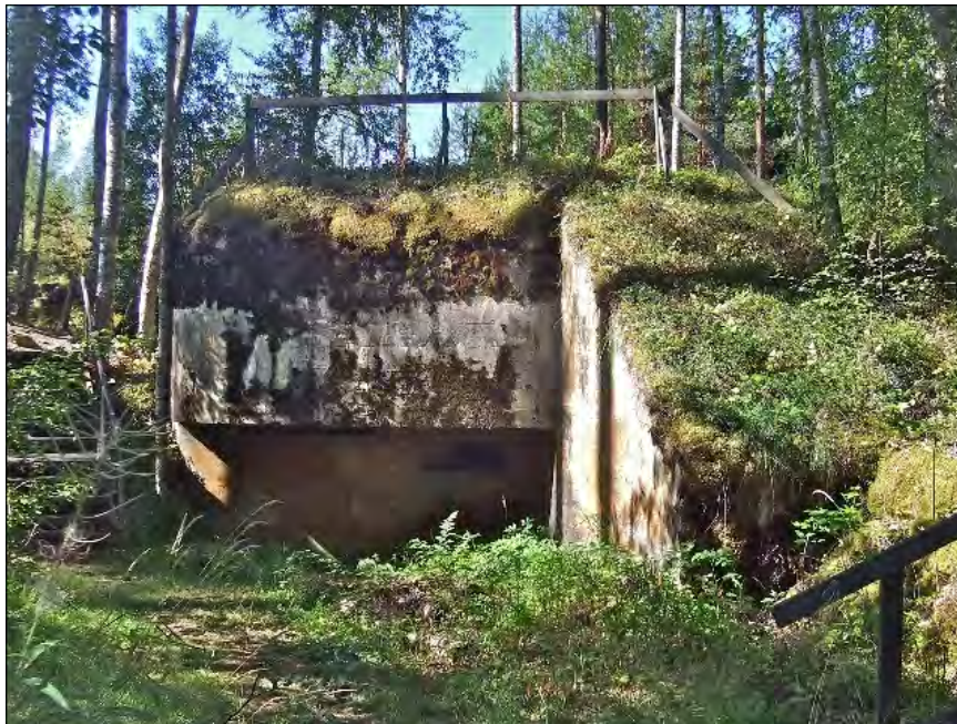
Kuva 114. Korsun 63 ampuma-aukko on kattolipan alla. Aseseinässä on naamiomaalaus. Kuva: John Lagerstedt 2010 / Museovirasto 217984:342.
