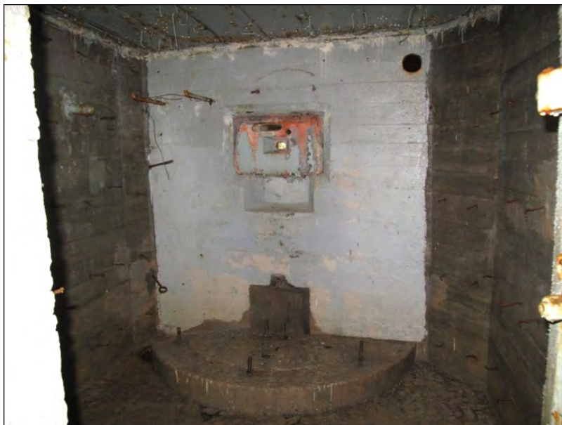
Kuva 62 Korsun 241 konekiväärin asekammio. Ampuma-aukko on varustettu aukkopanssarilla ja konekivääri on ollut teräksisellä korsujalustalla. Virolahti, Pulmikas. Kuva: Tiina Mikkanen 2010 / Museovirasto 217984:176
