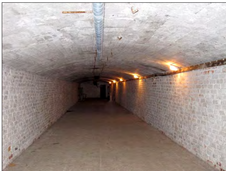
Kuva 96. Rutolan majoitustunnelin 131/143 seinät on verhoiltu tiilimuurauksella. Kuva: John Lagerstedt 2010 / Museovirasto217984:279.
