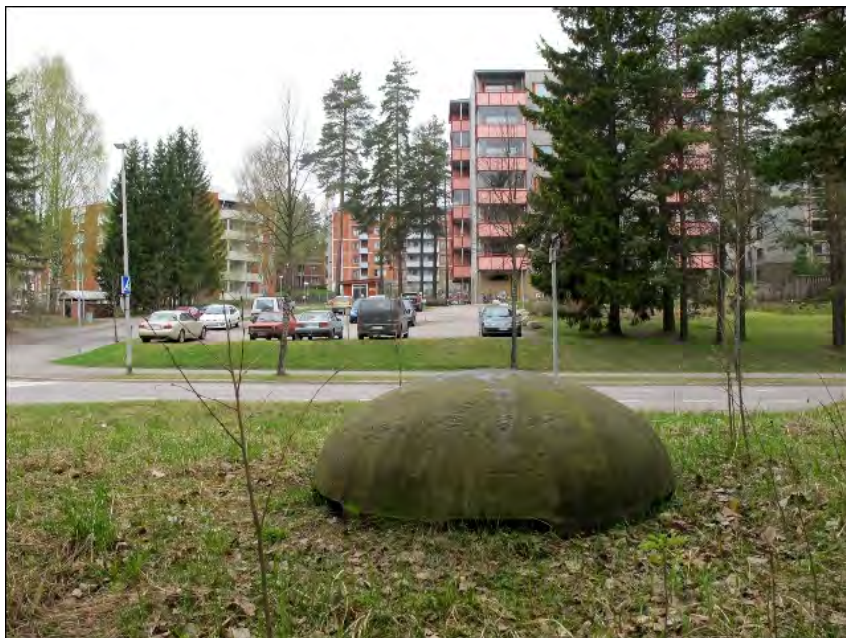
Kuva 100. Korsun nro 27 teräksinen, vuoden 1939 mallia oleva tähystyskupu Lappeenrannan Skinnarilassa. Korsun sisäänkäynti ja ampumasektori on peitetty maalla. Kuva: John Lagerstedt 2010 / Museovirasto 217984:297.
