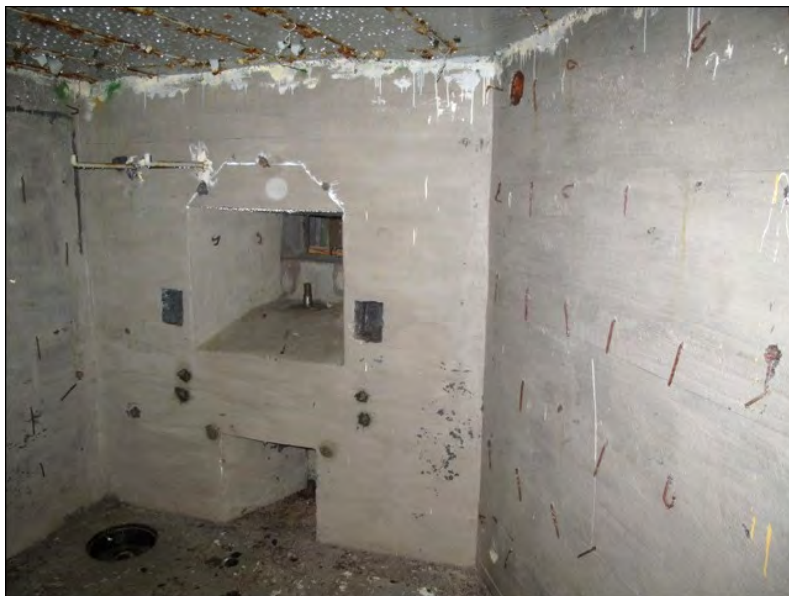
Kuva 60. Konekiväärin asekkamio. Ampuma-aukon vasemmalla puolella on seinässä jäähdytysvesias-tian kiinnitykseen tarkoitetut koukut. Seinässä on teräslankoja akustiikkamattojen kiinnitykseen. Katossa on metallilevyt. Virolahti, Pataniemi, korsu 31. Kuva: Tiina Mikkanen 2010 / Museovirasto 217984:167
