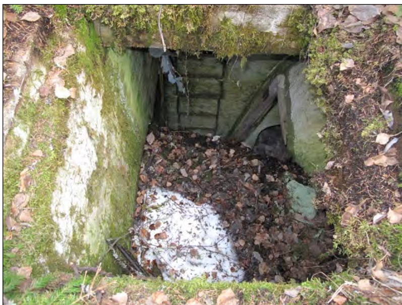
Kuva 63. Tulenjohtopesäkkeen 1053A avonainen tulenjohtokuilu pallokorsun nro 1816 yhteydessä Virolahden Pajulahdessa. Takaseinällä tikasaskelmat ja oikealla sisäänkäynti korsuun. Kuva: Tiina Mikkanen 2011 / Museovirasto DG2383:1.
