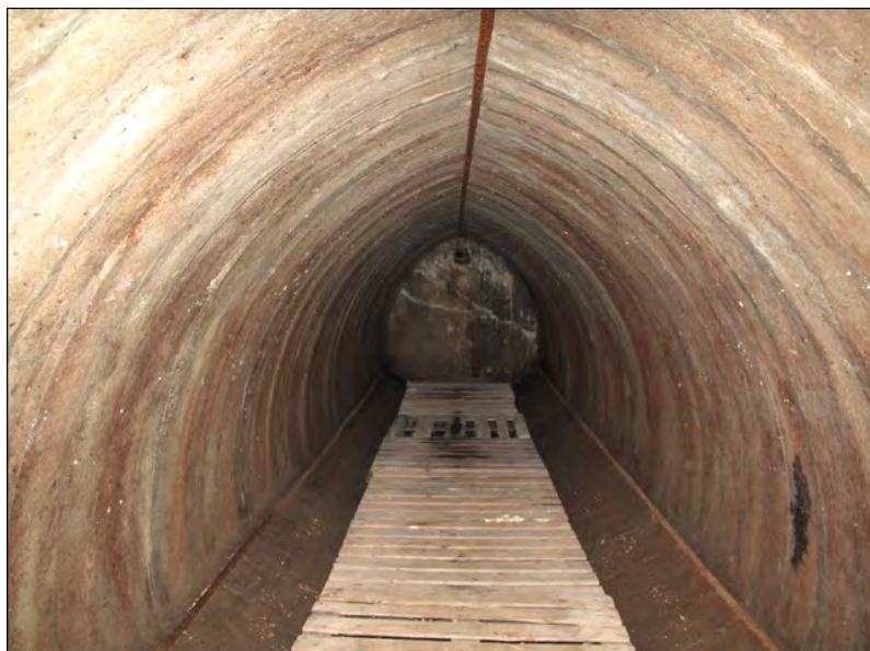
Kuva 82. Majoituskorsu nro 3000 on koottu betonisista lamellielementeistä Luumäen Orkolassa. Kuva: Tiina Mikkanen 2010 / Museovirasto217984:194.
