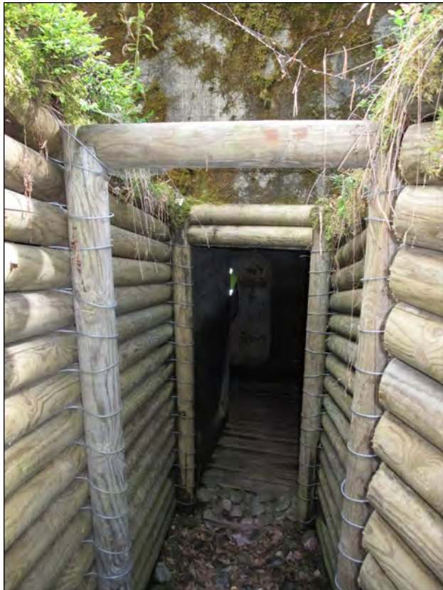
Kuva 105. Korsiin nro 6 sisäänkäynnin yhdyshauta on uudistettu myöhemmin Ruokolahden Palhoinniemessä. Kuva: Markus Kankkunen 2010 / Museovirasto 217984:254.
