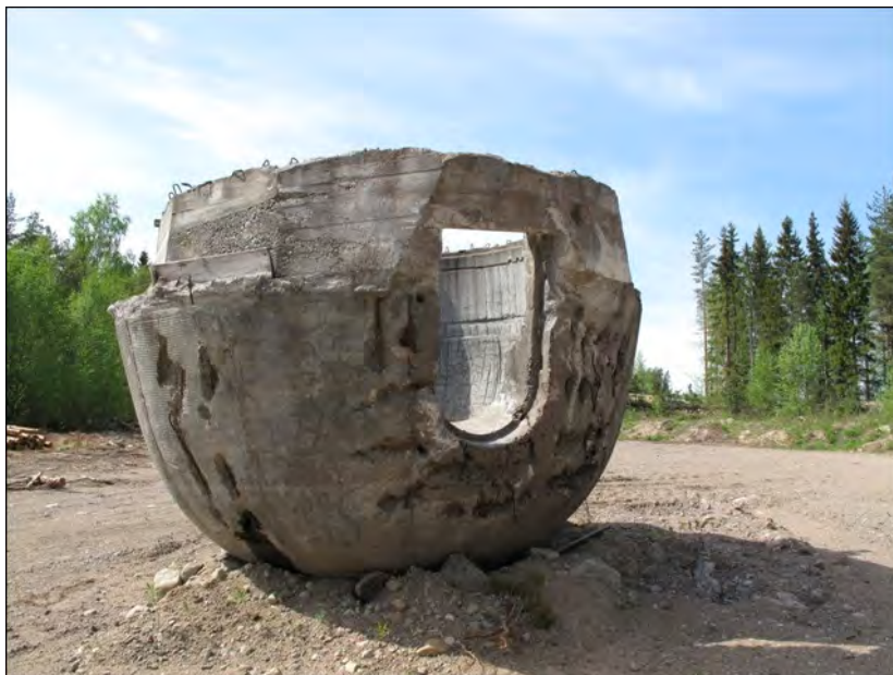
Kuva 97. Pallokorsu nro 155 on kellahtanut ylösalaisin, kun sen ympäriltä on otettu hiekkaa. Kuva: Tiina Mikkonen 2010 / Museovirasto 217984:267.
