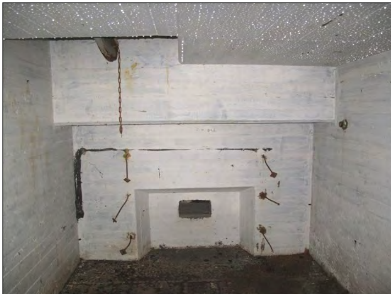
Kuva 69. Panssaritorjuntakiväärin aseammio Miehikkälän Riihimäen korsussa nro 308. Katossa vasemmalla aukko tähystyskupuun. Kuva: Tiina Mikkanen 2011 / MuseovirastoDG2425:2.
