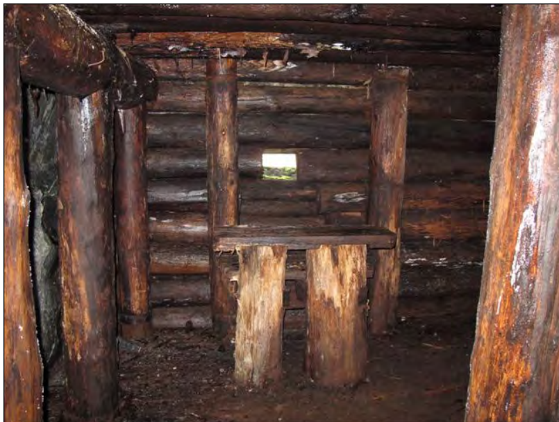
Kuva 124. Hirsinen konekiväärin asekammio Lieksan Vornosenvaaran majoitustunnelin alimmassa kerroksessa. Kuva: John Lagerstedt 2011 / Museovirasto DG2583:1.
