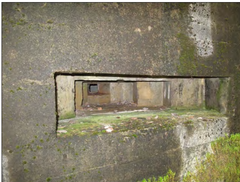
Kuva 53. Korsun 270 lähipuolustukseen tarkoitettu, sisäänkäynnin vieressä oleva ampuma-aukko ulkoapäin kuvattuna. Virolahti, Lakiasuo. Kuva: Tiina Mikkonen 2010 / Museovirasto217984:125.
