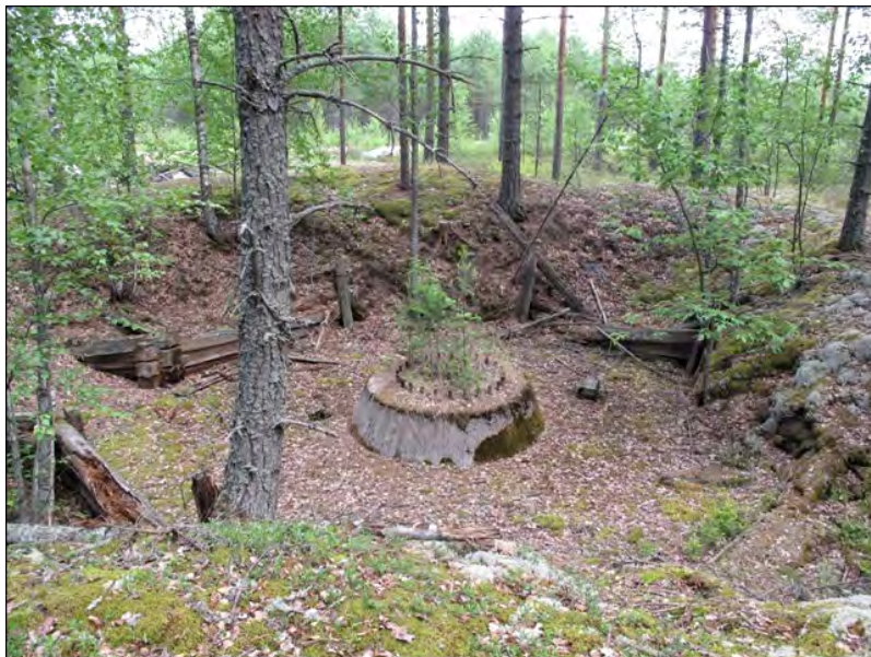
Kuva 104. Hirsillä tuettu tykkiasema, jonka tykinperusta on valettu betonista Taipalsaaren Vaivionkanalla. Kuva: Tiina Mikkanen 2010 / Museovirasto DG2538:1.
