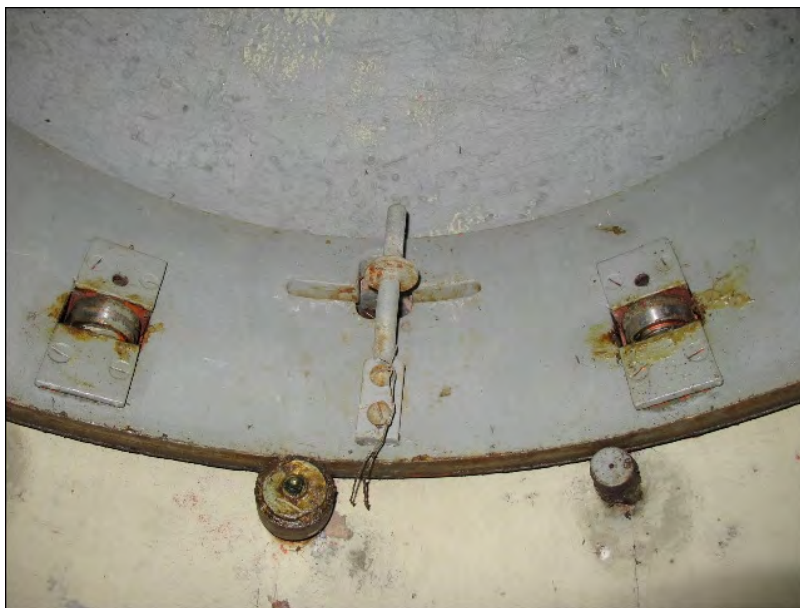
Kuva 112. Yksityiskohta vuoden 1939 mallisen tähystyskuvun sulkurenkaasta, jolla on voitu sulkea tähystysaukko tulituksen aikana. Kerimäki, Mäntylä, korsu 35. Kuva: John Lagerstedt 2010 / Museovirasto 217984:336.
