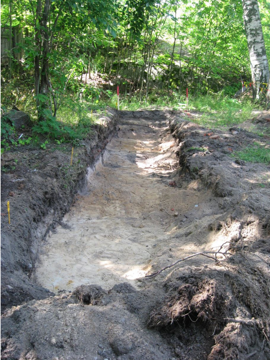
Kuva 26: Koeoja 3 pohjaan kaivettuna. NE. Kuva: KyM/M. Kykyri.
