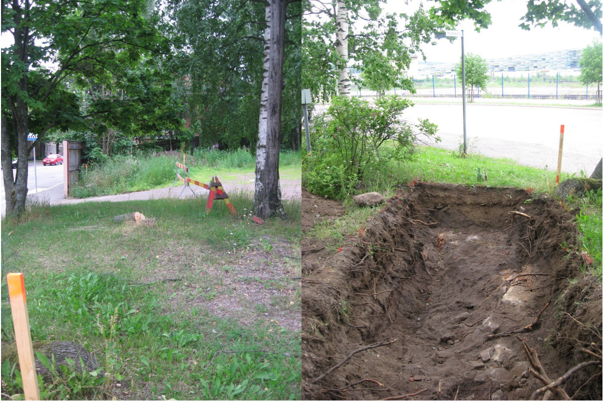
Kuvat 9-10: Koeoja 1 ennen kaivamista (vas., NW) ja kaivinkoneella syventämisen jälkeen kun sen NE-päässä sijaitsevan kiviperustuksen R5 pinta alkoi paljastua (oik.) SE. Kuva: KyM/M. Kykyri.
