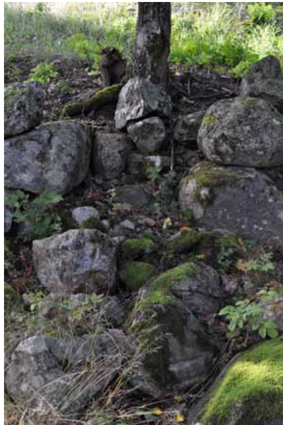
Kuva 12. Mahdollinen porttirakenne puisto- ja puutarha-alueen pohjoisen niittyalueen kalliisesta rinteestä erottavassa kiviaidassa, aidan läntisessä osassa. Kuvattu pohjoisesta. Mikko Helminen. TYA 29:11.
