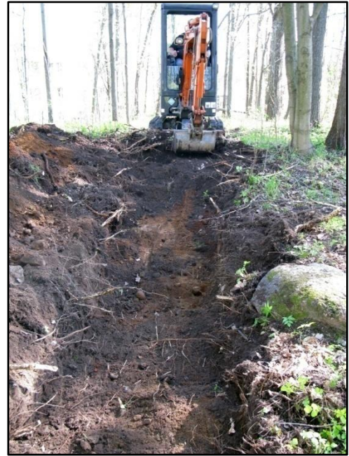
Rakennettavalle tontille kaivettiin koneellisesti pitkiä koeojia säilyneiden historiallisen ajan rakenteiden paljastamiseksi. Kuva: Satu Koivisto MV/ARKE.
