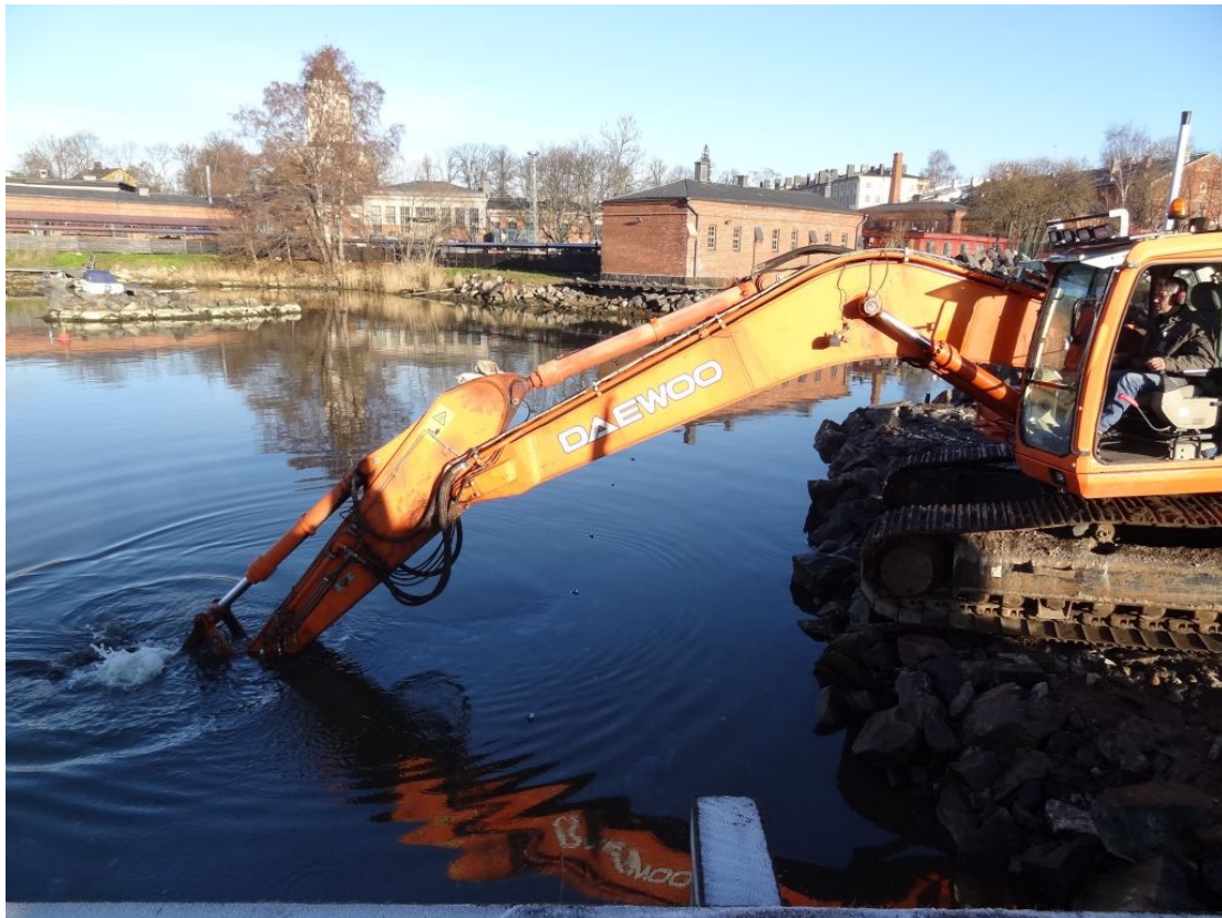
Kuva 9. Patorakenteen ulkoreunan edessä olleen hiekkavallin poistaminen kaivinkoneella. Kuva: Museovirasto MA201111:82.
