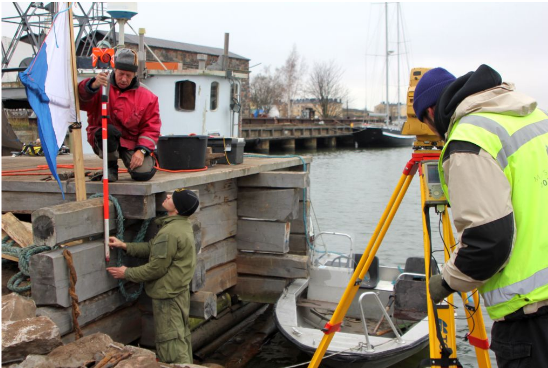
Kuva 7. Nollakoron mittaus ja merkitseminen Törnen laiturin pätyyn. Kuva: Museovirasto MA201111:69.
