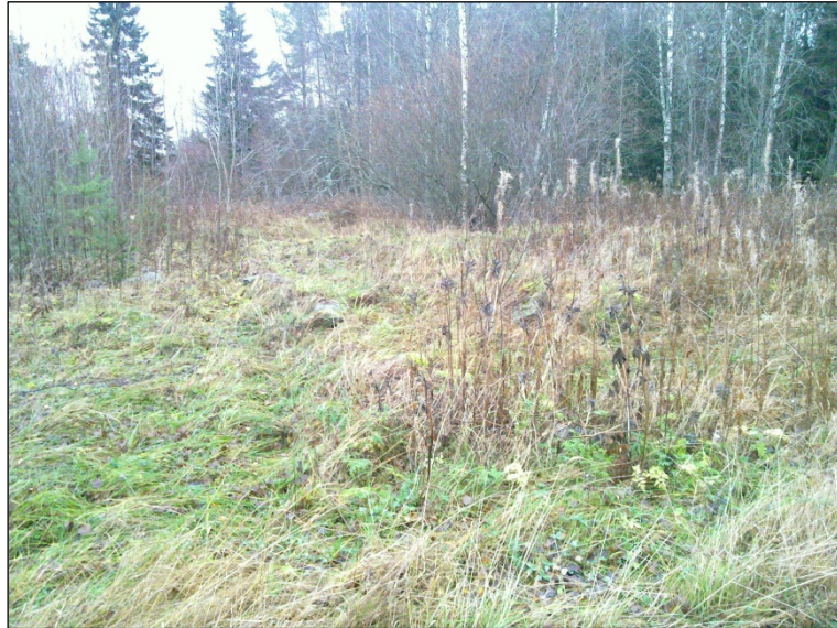
Pohjoispuolinen rakennuksen perusta
