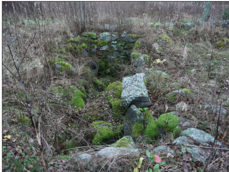
Tien eteläpuolisen rakennuksen kellari
