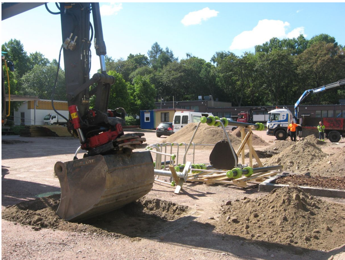
Kuva 7: Saneeraustyöt käynnissä. N. Kuva: KyM/M. Kykyri.
