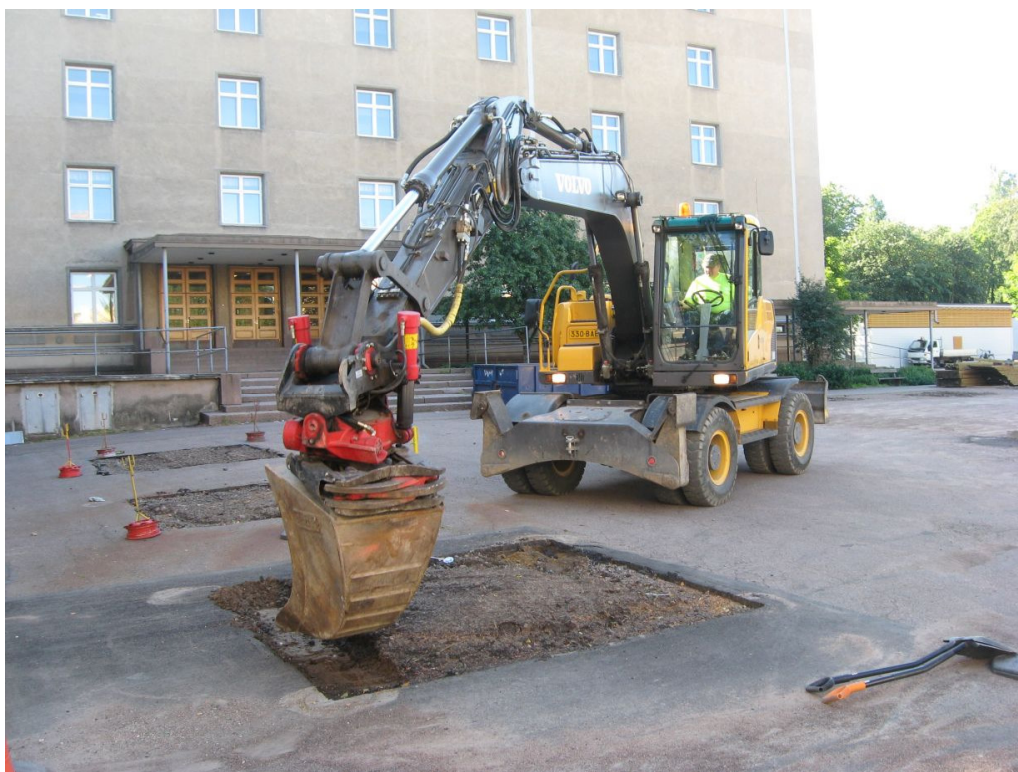
Kuva 16: Istuintasojen/istutuslaatikoiden kaivutyötä pihan NE-sivustalla. N. Kuva: KyM/M. Kykyri.
