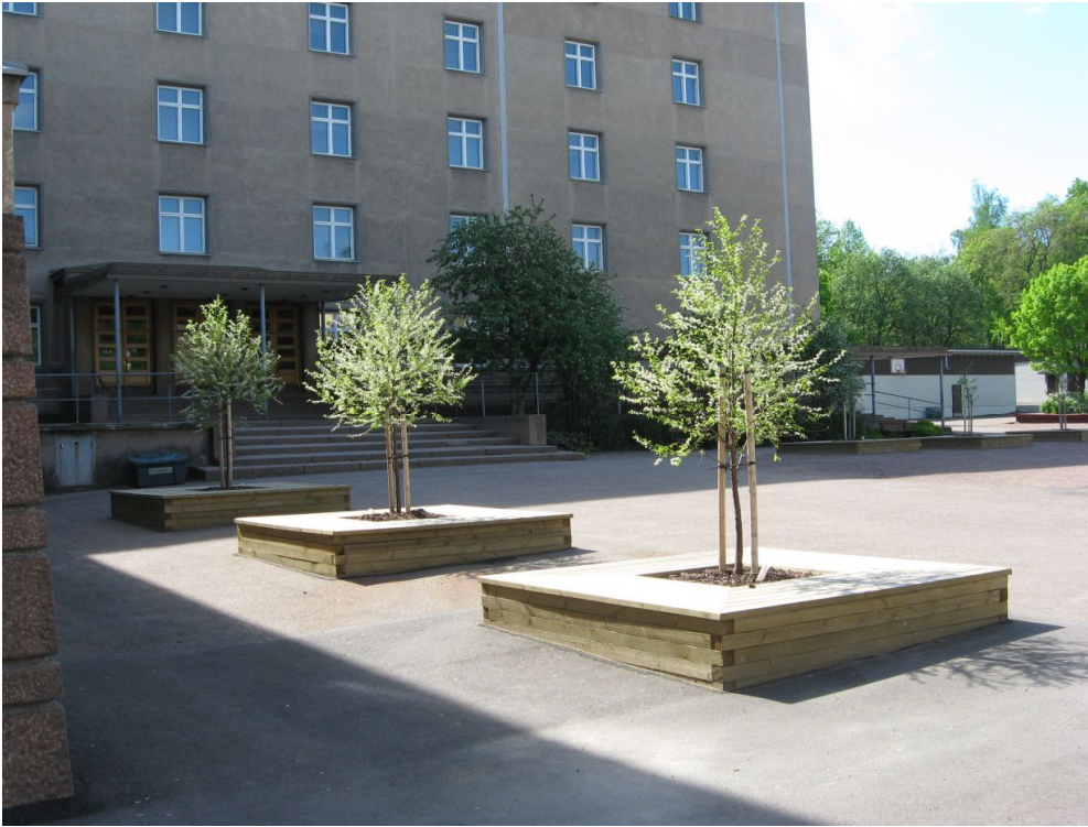
Kuva 17: Istuintasot/istutuslaatikot valmiiksi rakennettuna. N. Kuva: KyM/M. Kykyri.
