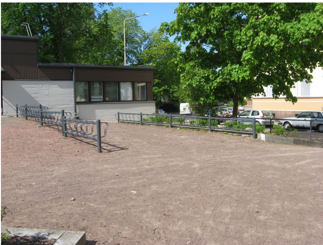
Kuva 19: Pyörätelineet valmiiksi asennettuina. E. Kuva: KyM/M. Kykyri.
