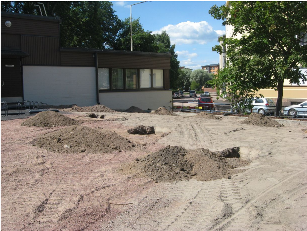
Kuva 18: Pyörätelineitä varten kaivettuja perustuskuoppia pihan W-nurkassa. E. Kuva: KyM/M. Kykyri.
