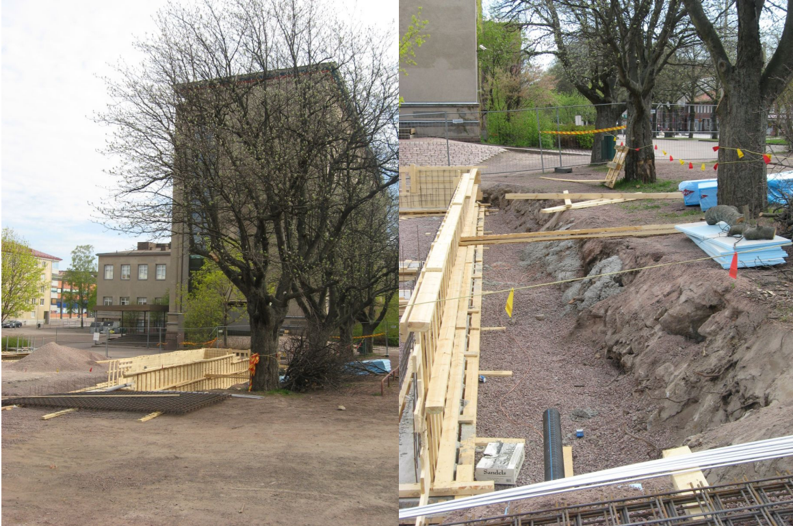
Kuvat 25-26: Jätekatos rakenteilla (vas.). S. Oikealla katoksen SE-sivustaa, jonka seinämässä erottuu paksu lohkokivitäyttökerros. SW. Kuva: KyM/M. Kykyri.
