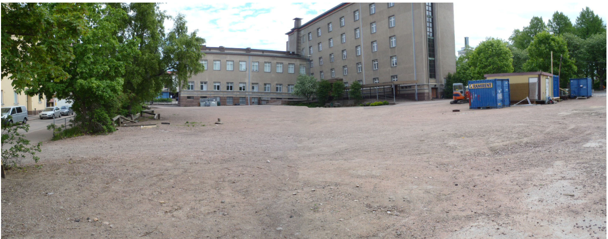
Kuva 3: Keskuskoulun piha-alue ennen kesäkuussa 2011 alkaneita saneeraustöitä. W. Kuva: KyM/M. Kykyri.
