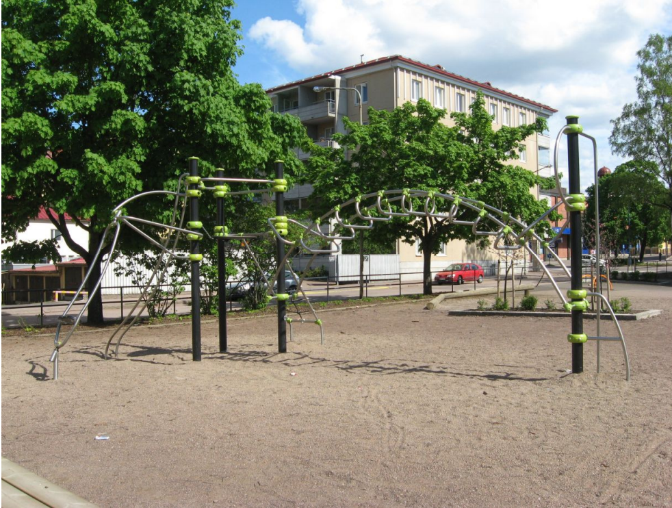
Kuva 13: Monitoimiteline valmiiksi asennettuna. S. Kuva: KyM/M. Kykyri.
