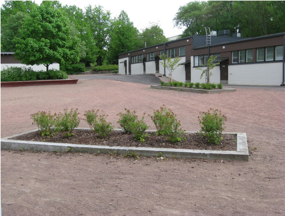
Kuva 24: Istutusaltaat D ja E valmiiksi rakennettuina. NW. Kuva: KyM/M. Kykyri.
