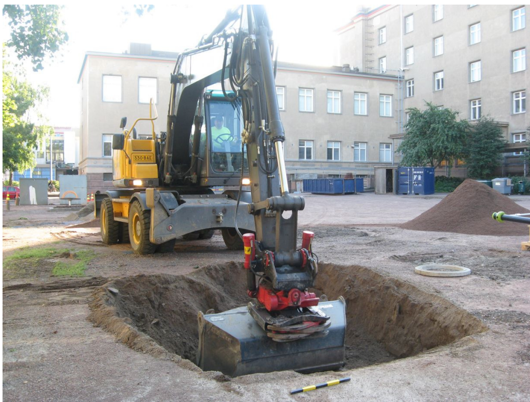
Kuva 8: Telinekuoppaa K1 kaivetaan. W. Kuva: KyM/M. Kykyri.
