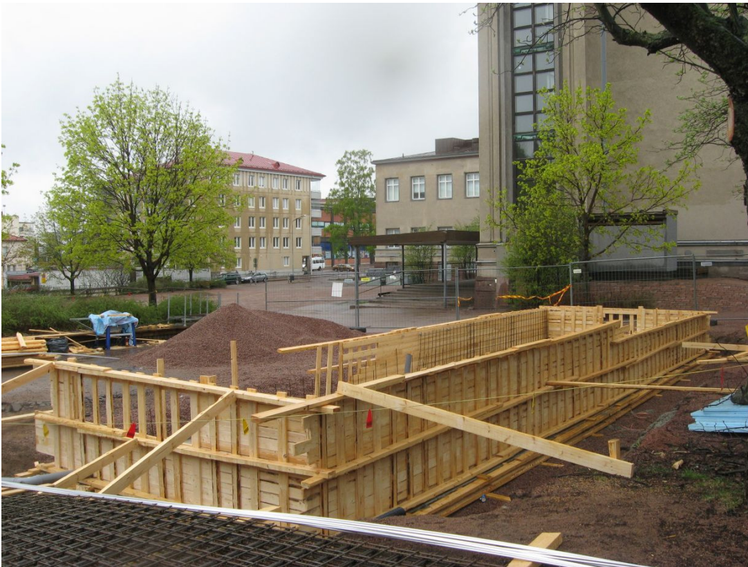
Kuva 2: Jätekatoksen rakennustyöt käynnissä koulutontin SE-sivustalla toukokuussa 2011. S. Kuva: KyM/M. Kykyri.
