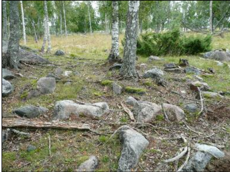
Rakennuksen pohjan kiviperustusta.
