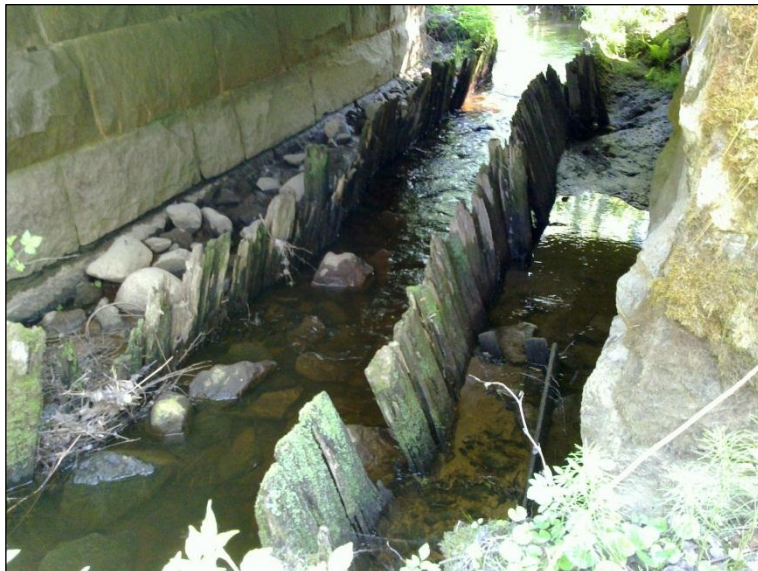
Paukajoen silta kuvattu viitostien suuntaan joka taustalla. Kiviarkkuisen Sillan alla uomassa puurakenteita – olisivatko jäänteitä aiemmasta puusillasta?
