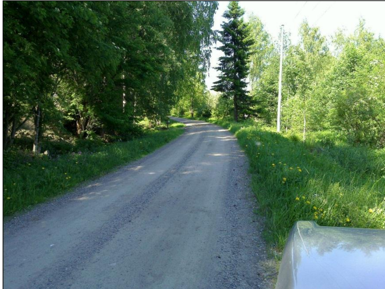
Vanhaa tietä, nyt Paukarlahden kylätietä Väinölän talon pohjoispuolella
