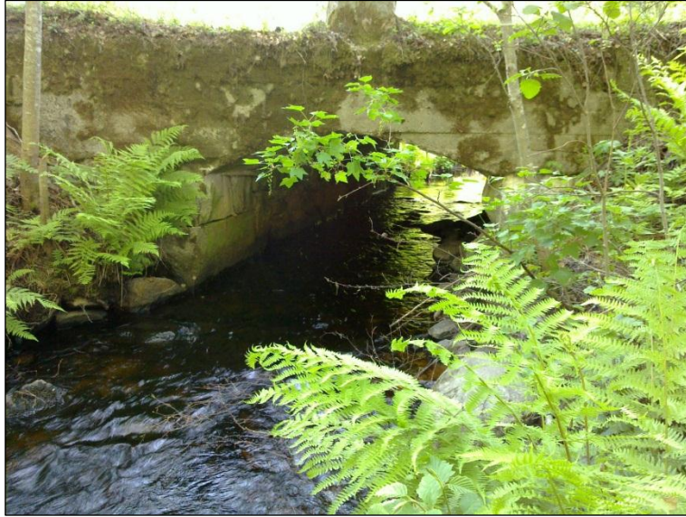
Humalajoen sillan rakennetta
