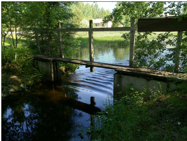
Kanavan suu Myllylammen eteläpuolella.
