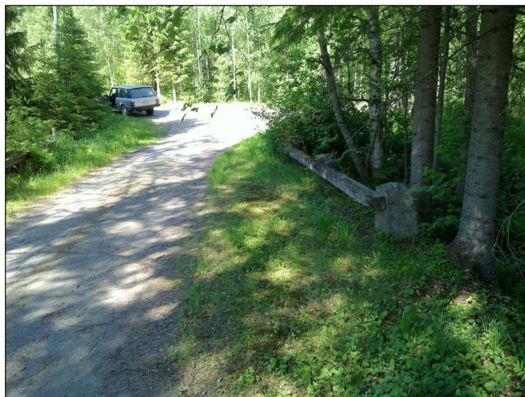
Humalajoen silta, pohjoiseen.
