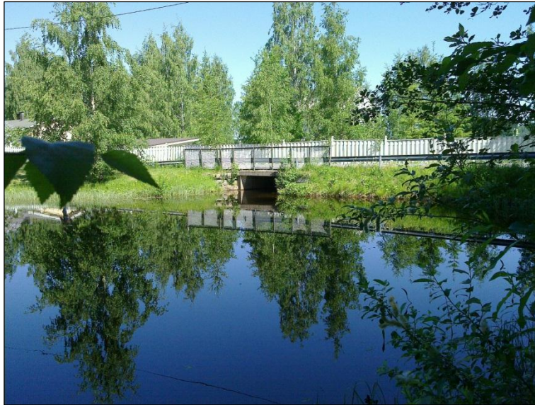
Lampi kanavan itäpäässä, tien alla pato ja takana koski Oravilahteen
