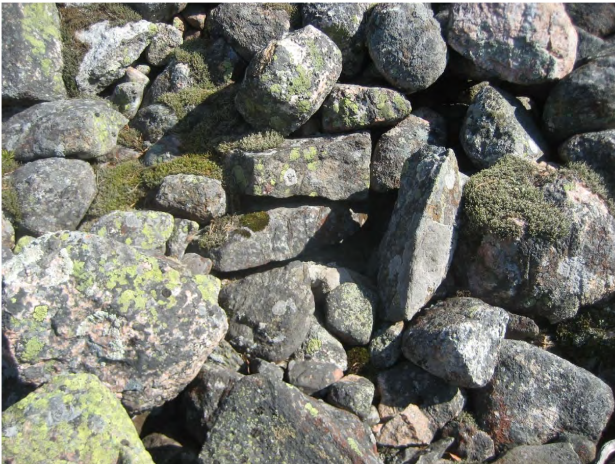
Kummelberget rökkiön 1 kivivaipassa näkyvää mahdollista kylmämuurattua seinää.
