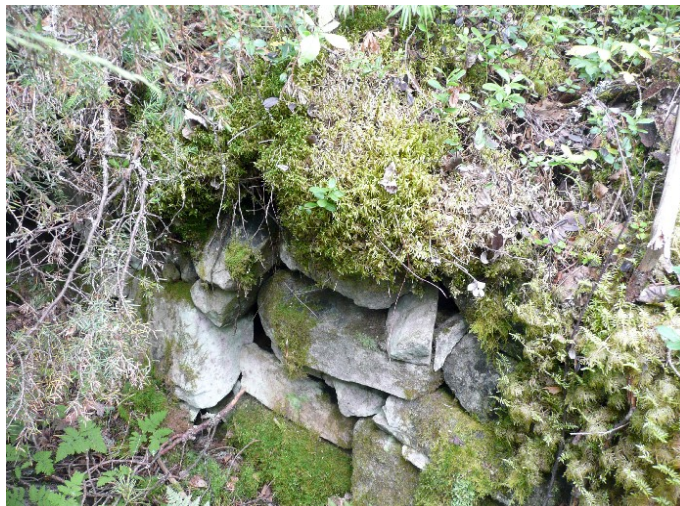
Kuva 8. Kellarikuopan seinämän kylmämuurausta.
