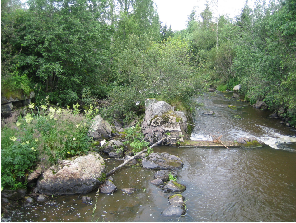
Kuva 11. Rekikoski. Pato. Keskellä pilarirakenne ja vasemmalla rannalla kiviperustusta (samanlainen oikealla rannalla). Kuva T. Vasko.
