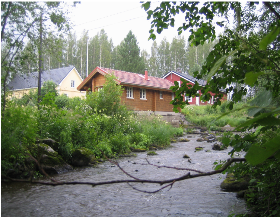
Kuva 3. Nanhiankoski. Saunarakennus myllyn perustuksilla. Vieressä pato. Kuva T. Vasko.
