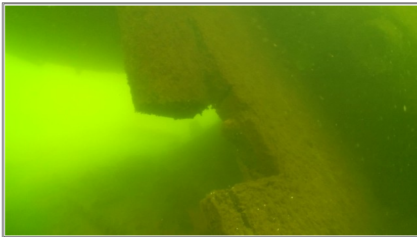
Kuva 7. Peräsin, vannasputken pää oikealla. Potkuri ja potkuriakseli poistettu. Kaappauskuva videotiedostosta 20120722211451.m2t. Kuvaaja Rami Kokko / ARK-sukellus.
