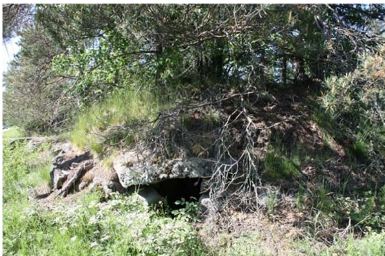
DG2636:1 Kivikellari tien vieressä, suuaukko. Kuvattu kaakosta. Kuva Katja Vuoristo.
