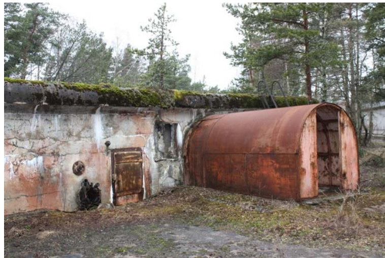
DG 2631:13 Rautainen suojakatos betonivarustuksen itäosassa. NE-SW. Kuva Katja Vuoristo.
