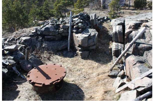
DG 2631:54 Poteromainen suojakiveys tykkiaseman ympärillä ja yhdyskäytävä. E-W.
