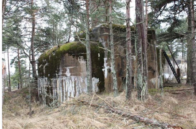
DG 2631:17 Tykkipatterin itäpäädyn komentotorni. N-S. Kuva Katja Vuoristo.
