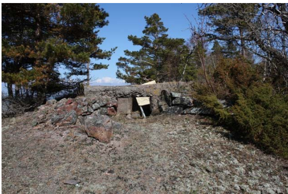
DG 2631:23 7-kulmainen asema länsirannalla. S-N. Kuvat Katja Vuoristo.
