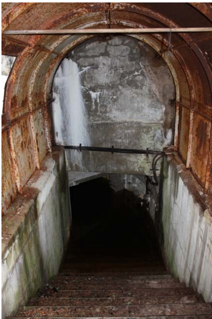
DG 2631:7 Tykkipatterin läntisimmän osan sisäänkäynti. Varustuksen sisäosa on täyttynyt vedellä ja se ulottuu portaiden alaosaan saakka. NW-SE. Kuvat Katja Vuoristo.
