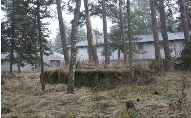
DG 2631:89 Mahdollisen sammutusvälinevaraston ja öljyliiterin perustusta. NW-SE. Kuva Katja Vuoristo.
