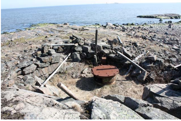
DG 2631:53 Pyöreän betonialustan päällä oleva rautainen kiinnitysalusta ja asemaa ympäröivä suojakiveys. NW-SE. Kuvat Katja Vuoristo.
