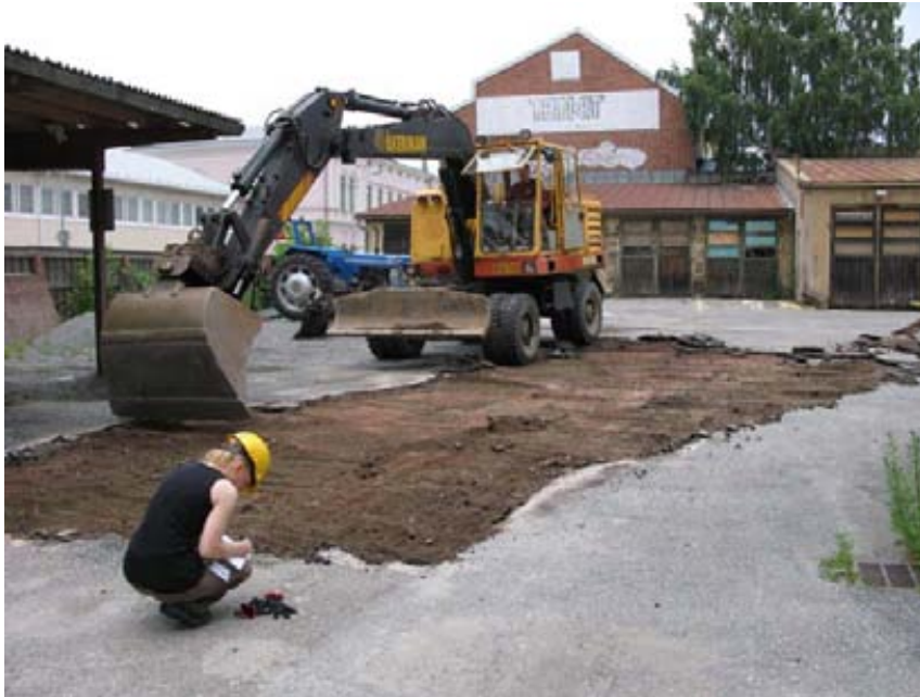
DG2247: 394. Asfaltin kuorintaan kaivausalueen A kohdalta.
