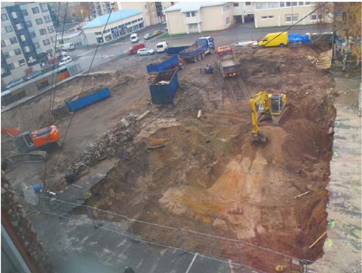
DG2247:16 Yleiskuva tontista 24.10.2011. (Kuvattu viereisellä tontilla sijainneen virastorakennuksen 4. kerroksen ikkunasta.) Annankadun Kulttuuritalon ("Annis") eteläpääty betonivalumuotteineen näkyy kuvan oikeassa yläkulmassa. Vasemmassa reunassa on käynnissä Funkkistalon purku. (MV/ARKE, T. Tanska, suunta 260)
