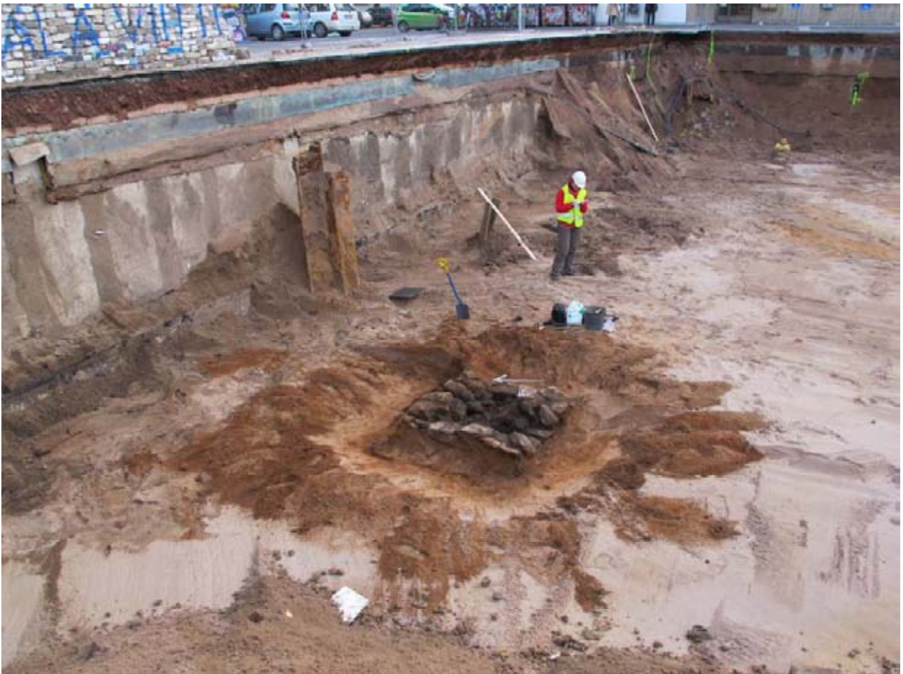
DG2247: 38. Kaivon sijainti tontilla. Kaivon koillispuolella näkyy paikalla sijainneen autohallirakennuksen suuri rautainen betonikengitetty antura. (MV/ARKE, S. Hujanen, suunta 100)
