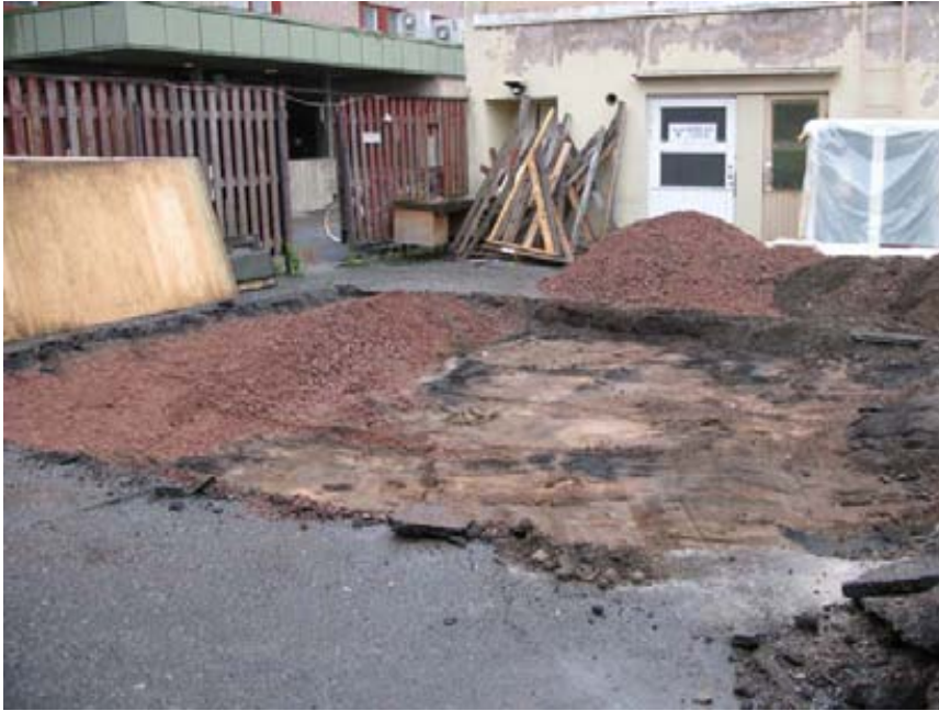
DG2247:397. Kaivausalue C kuorittuna pintamaista. Vasemmalle jää moderni kaivanto CRP1 ja sen täyttö CSY5.
