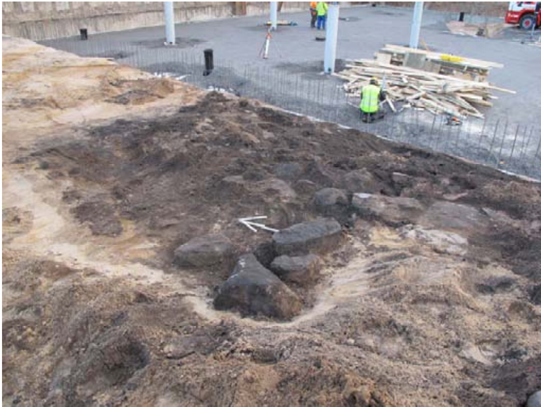
DG2247:318. Rakenne R18 ja SY59 ja SY60. (MV/ARKE, S. Hujanen, suunta 60)
