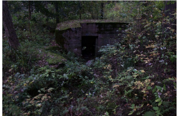
DG2710:5. Tukikohta XXIII:7, pohjoisosa. itäinen suojahuone (suojahuone 1). Itään. Kuvaaja Mikko Suha.
