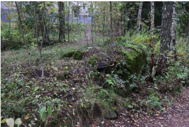
DG2709:9. XXIII:5 koillisosa. Tuhotun suojahuoneen kattoa ja rintamanpuoleista ulkoseinää. Länsilounaaseen. Kuvaaja Mikko Suha.
