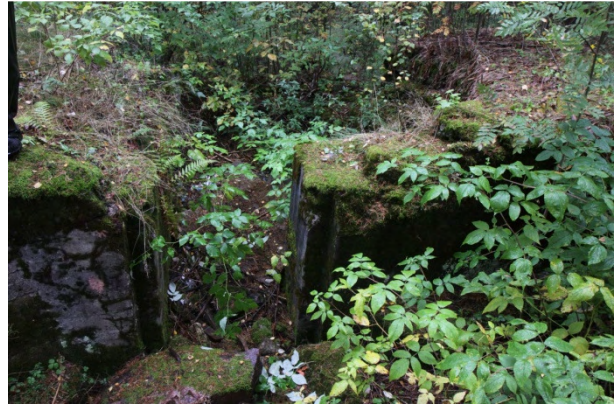
DG2709:5. Kk-pesäke 2. Taustalla näkyy tuhoutunut ampumaaukko. Pohjoisluoteeseen. Kuvaaja Mikko Suha.
