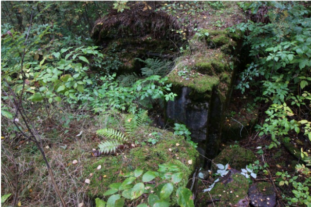
DG2709:4. Toinen kk-pesäke 2, ampumatarvikekomeron yläpuolella vielä ratakiskon pätkä jäljellä. Myös tuhoutunut katto näkyy. Koilliseen. Kuvaaja Mikko Suha.
