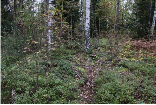
DG2708:3. Suojavalli on matalimmillaan neljännessä osassa, lankaeste on kulkenut vasemmalla näkyvässä kaivannossa. Valli on käytännössä maanpinnan tasainen, koostuen vain louhintajätteestä. Luoteeseen. Kuvaaja Mikko Suha.
