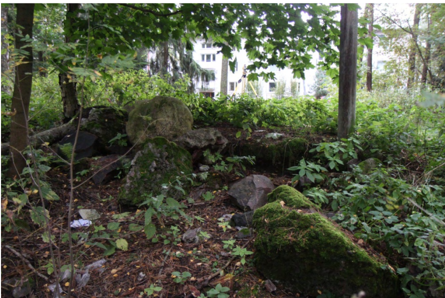
DG2709:11. Toinen suojahuone edellisestä noin 20 metriä itään. Pylvään vieressä on kattoa mahdollisesti paikoillaan. Etelään. Kuvaaja Mikko Suha.
