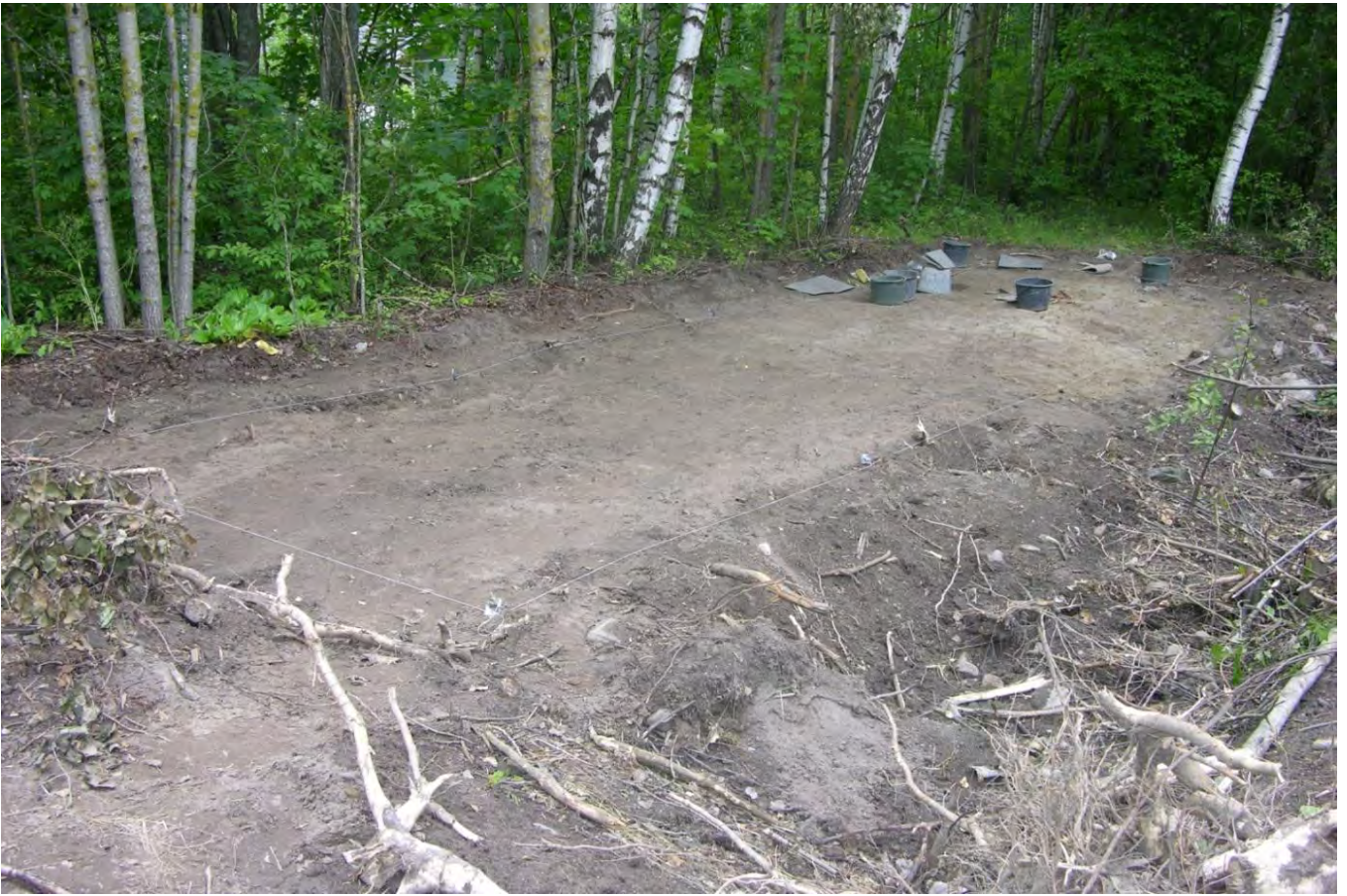
Alue 2 pintamaan poiston jälkeen. Etelästä. DT2012:63:19. Kuva Mika Ainasoja.
