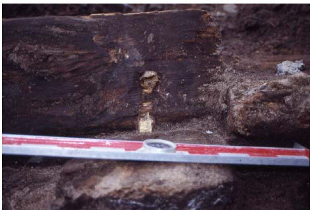
Diat 125511:33 ja 34. Samassa hirressä olevat salvokset ja tappikiinnitykset (Y8b).
