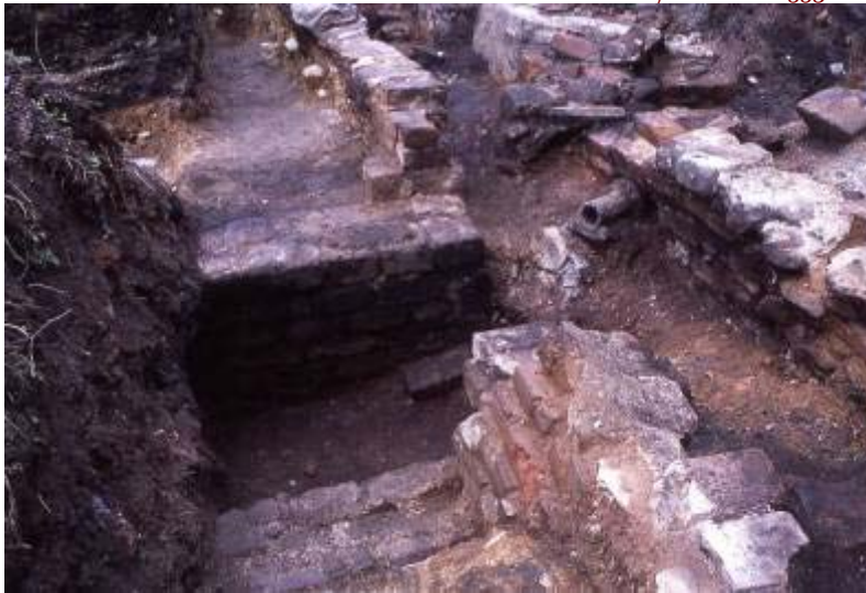
Kuva 6: Masuunin perustuksesta etelään päin suuntautuva putkikanava. V.-P. Suhonen
