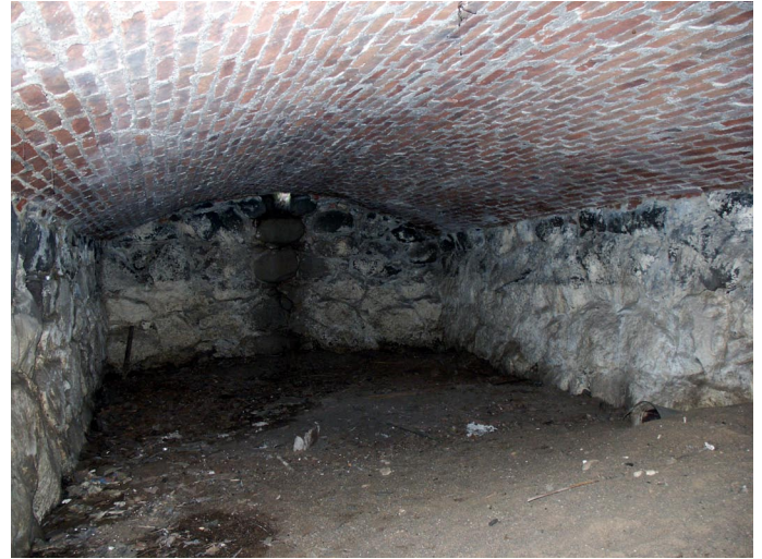
Kuva 256. Kellarin läntinen huonetila.
