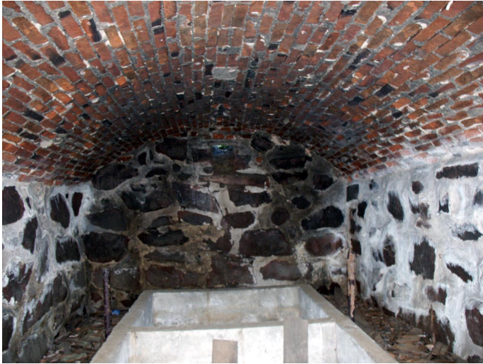
Kuva 255. Kellarin pohjoinen huonetila.
