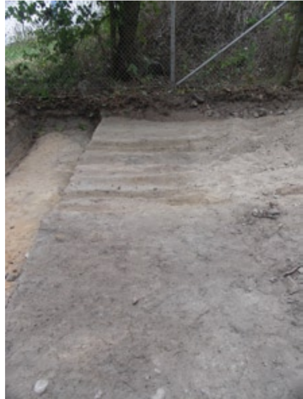
Kuva 21: Alueella 3 havaitut tiekerroksen urat.
