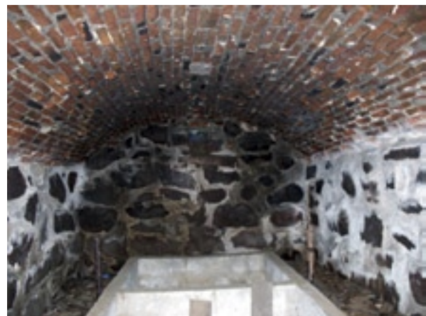
Kuva 24: Kellarin tynnyriholvattu pohjoinen huone.
