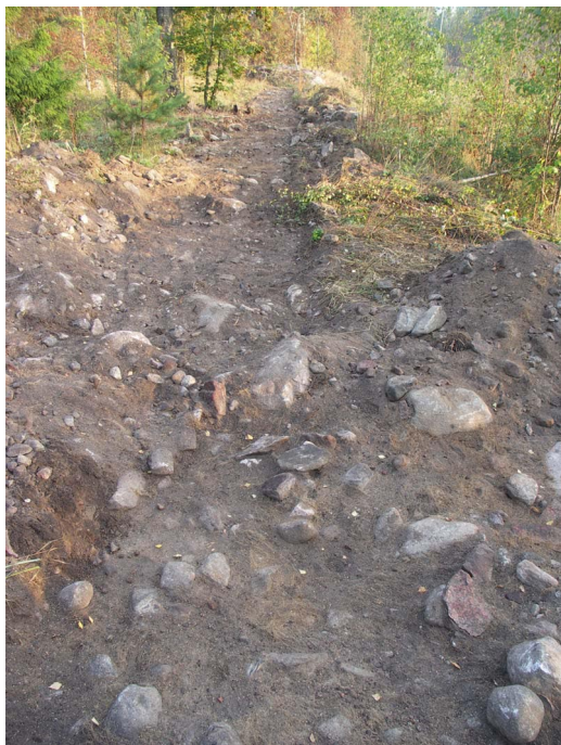
Kuva 250. Alue 5. Pintamaa poistettu.
