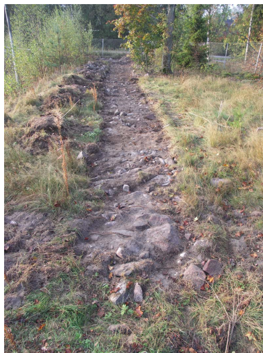
Kuva 249. Alue 5. Pintamaa poistettu.
