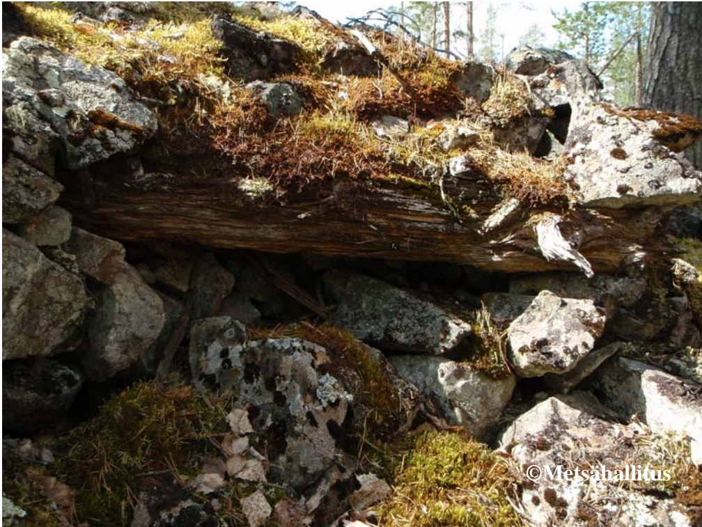
Kuva 12. Pitsloma 3. Valtauspaaden sisäosan puurakennetta.
