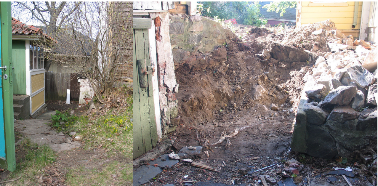
Rakennusten väli ennen kaivamista ja kaivamisen jälkeen
