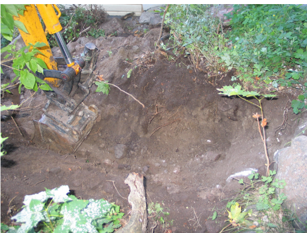
Rinteen harmaavesiviemäriin kaivantoa
