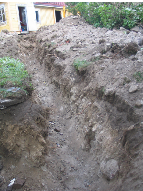
Kuvat ylhäältä alas: Kaivanto päärakennuksen luoteispuolella lounaispäädyssä kaakkoispuolella
